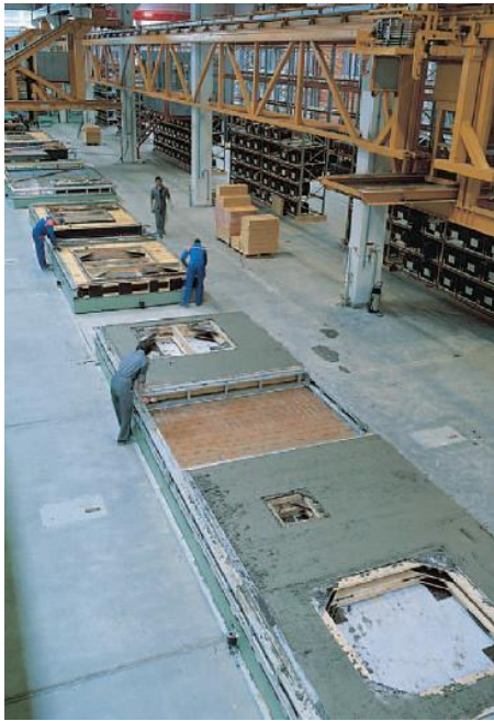
Kuva 29 Julkisivuelementtien valmistusta lähde: Betoni, perustietoa arkkitehtipiskelijälle
