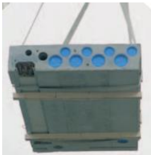
Kuva 28 Talotekniikkaelementti, lähde: Elpotek Oy
