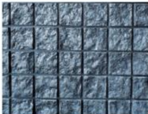
Kumimuottiin valettu värabetoni
