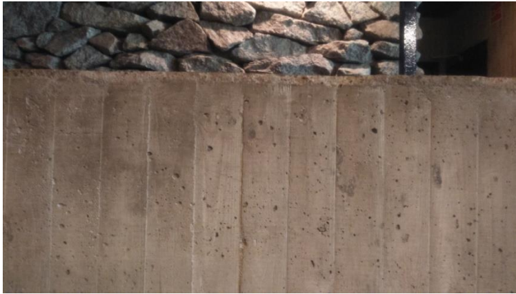
Kuva 41 Sahatavaramuottia vasten valettu pinta Hotelli Mesikämmenessä Ähtärissä
