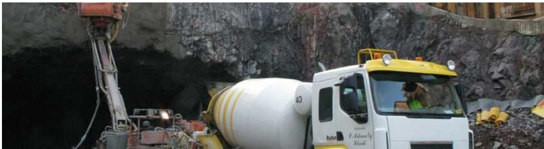
Kuva 54 Ruiskubetonointia tunnelin suulla lähde: Rudus Oy
