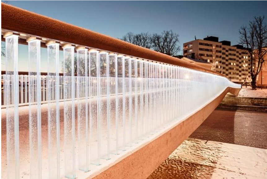
Kuva 64 Turun kirjastosilta, lähde: Betoniteollisuus Ry kuvaaja: Tuomas Uusheimo
