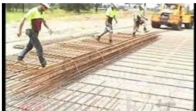
Kuva 3. Kuvassa on esitelty mattoraudoitteen asentaminen [22].
