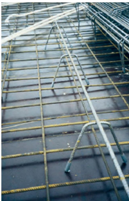
Kuva 4. Kuvassa on esivalmistettu tukipukki mattoraudoitteen yläpinnan tukemiseen [1].
