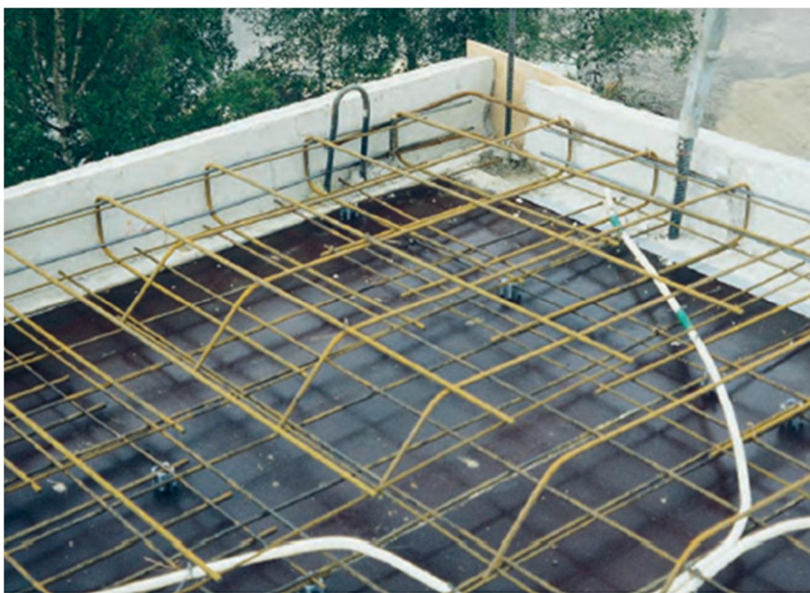
Kuva 5. Laatan reunalle asennettava hakakori [1].
