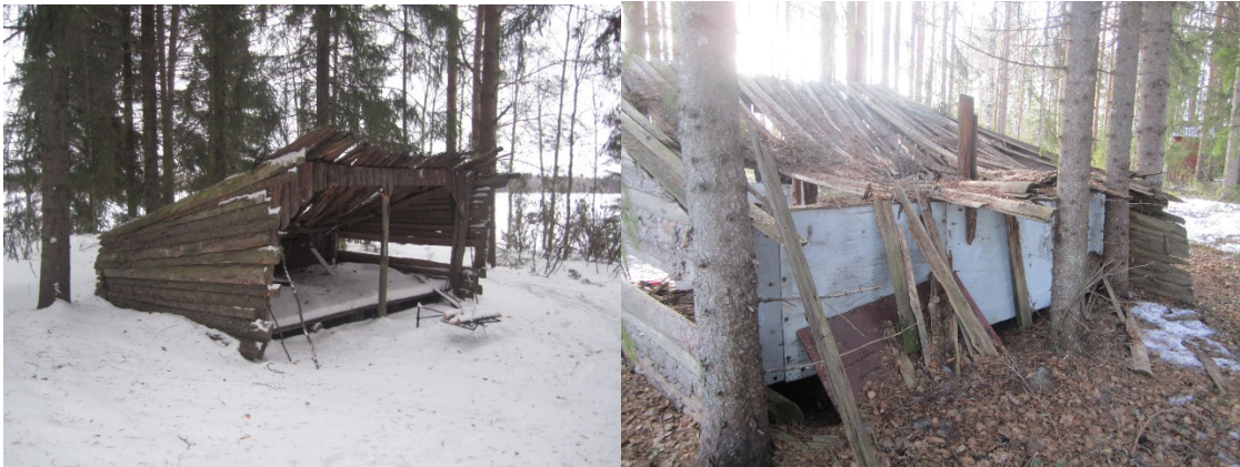
KUVIO 4. Laavu on huonokuntoinen ja katto on painunut sisään. Vasen kuva: Tuukka Kivioja
