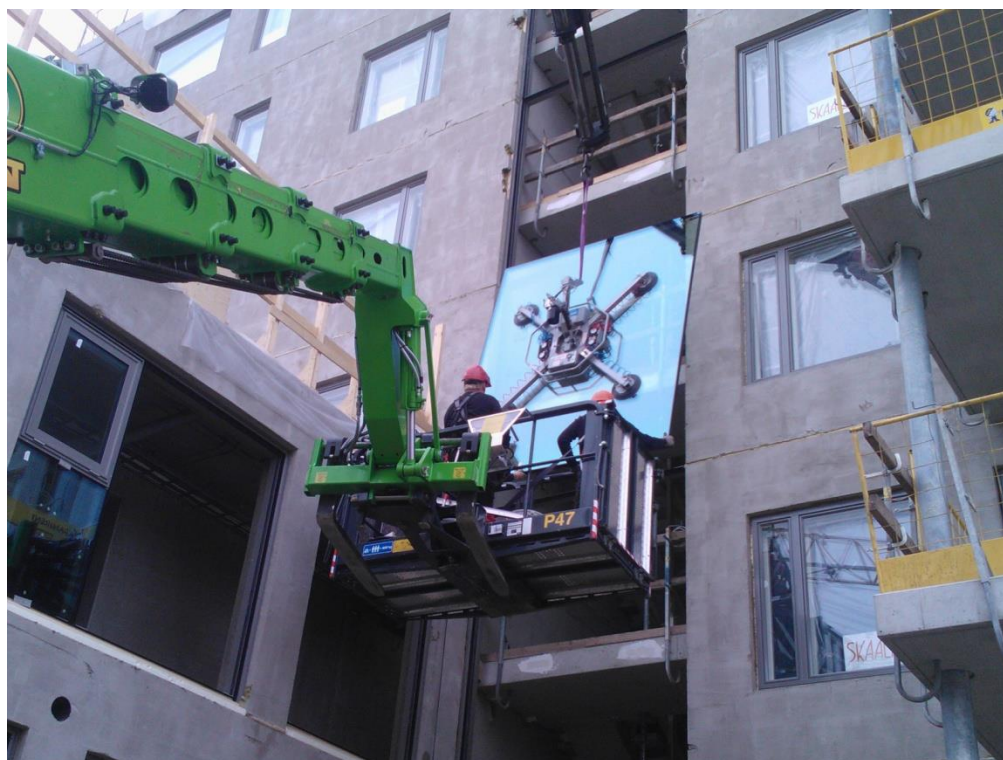
Kuvio 19. Imukuppi pysyy lasissa kiinni alipaineella.
