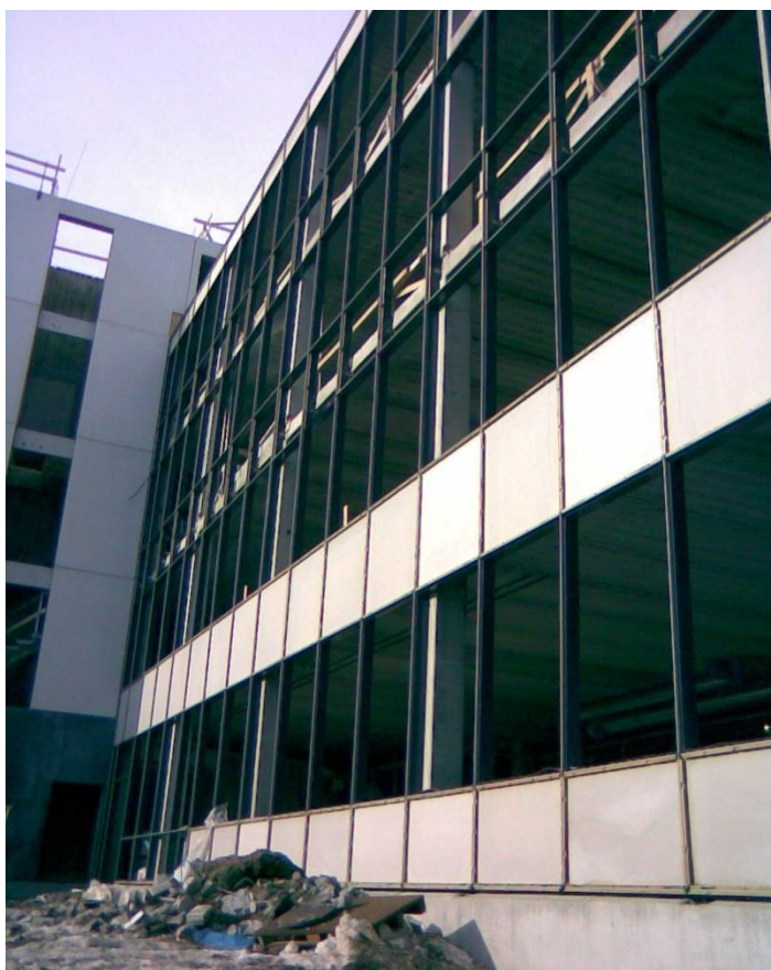
Kuvio 18. Seinä kasattuna ja kiinnitettynä lopulliseen tilaansa.
