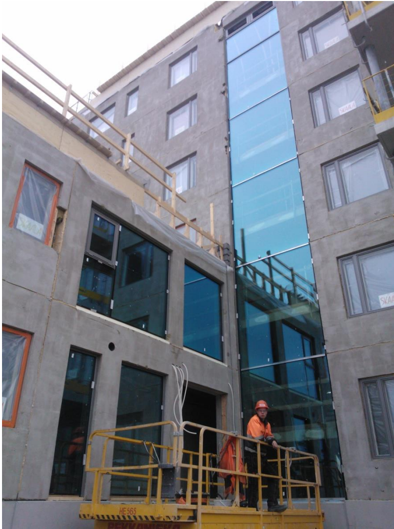
Kuvio 21. Seinä lasitettuna ja vaakalistat ruuvattuina paikoilleen.
