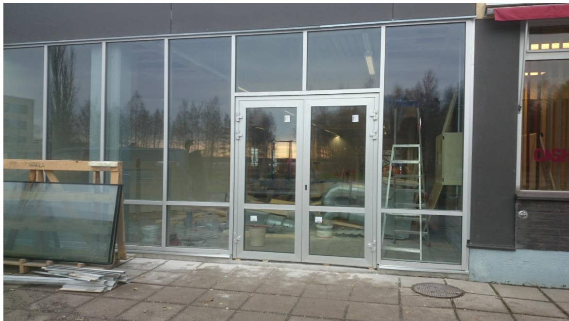
Kuvio 12. Alumiiniovi ikkunaseinään asennettuna.
