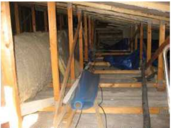
Katon vuotokohdassa oli käynnissä yläpohjan kuivaus / korjaustyöt.
