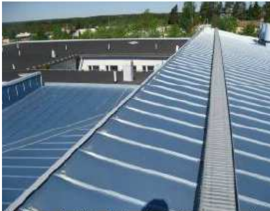
Yleiskuva katolta, katemateriaaleina saumattu pelti ja taustalla sirotepintaista bitumihuopaa.
