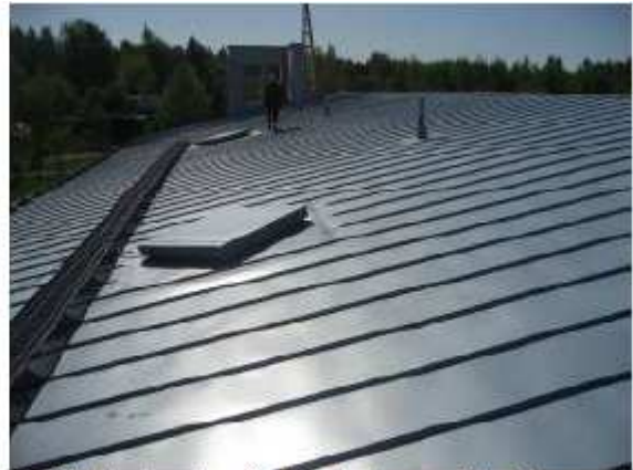
Peltikattopinnot vaikuttivat olevan siistejä ja kunnossa...
