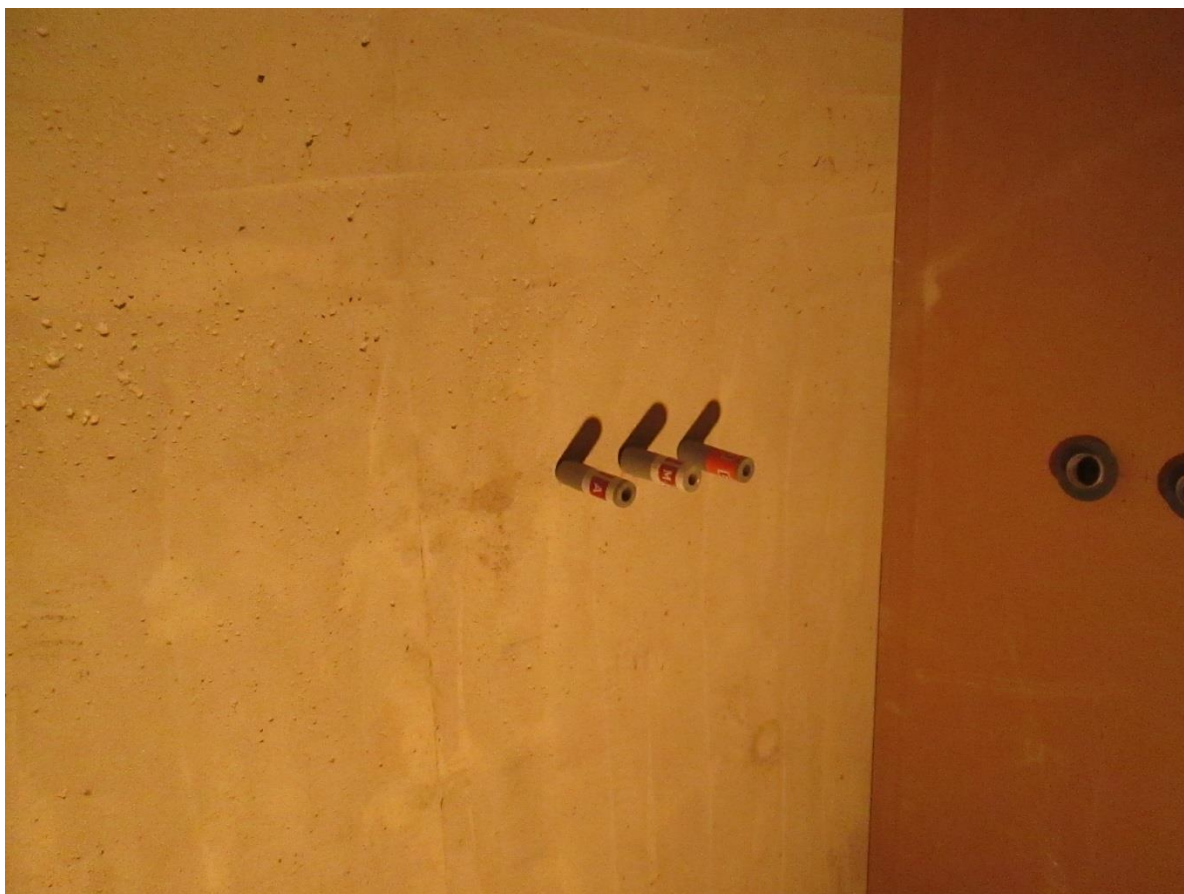
KUVA 4. Kosteusmittauspiste kylpyhuoneenseinässä. (Hakkarainen 2015-03-10.)
