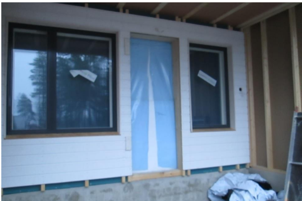
KUVA 12. Oviaukon suojaus muovilla ja lämmöneristeellä (Hakkarainen 2015-03-10.)
