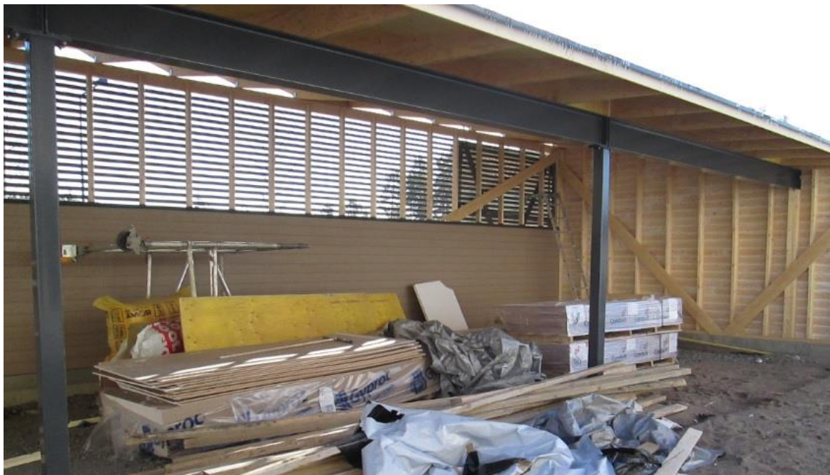
KUVA 2. Rakennusmateriaalien suojaus autokatoksessa ja lisäsuojaus kevytpeitteellä työpäivän jälkeen (Hakkarainen 2015-03-17.)
