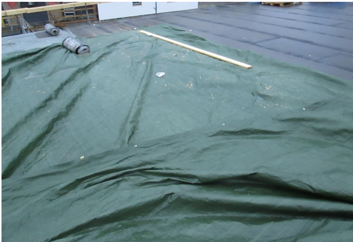
KUVA 13. Huovanalusvanerin suojaus (Hakkarainen 2014-11-05.)
