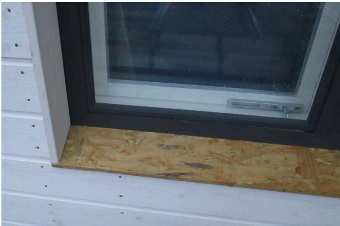
KUVA 10. Ikkunan alalaidan suojaus vanerilla (Hakkarainen 2015-03-10.)
