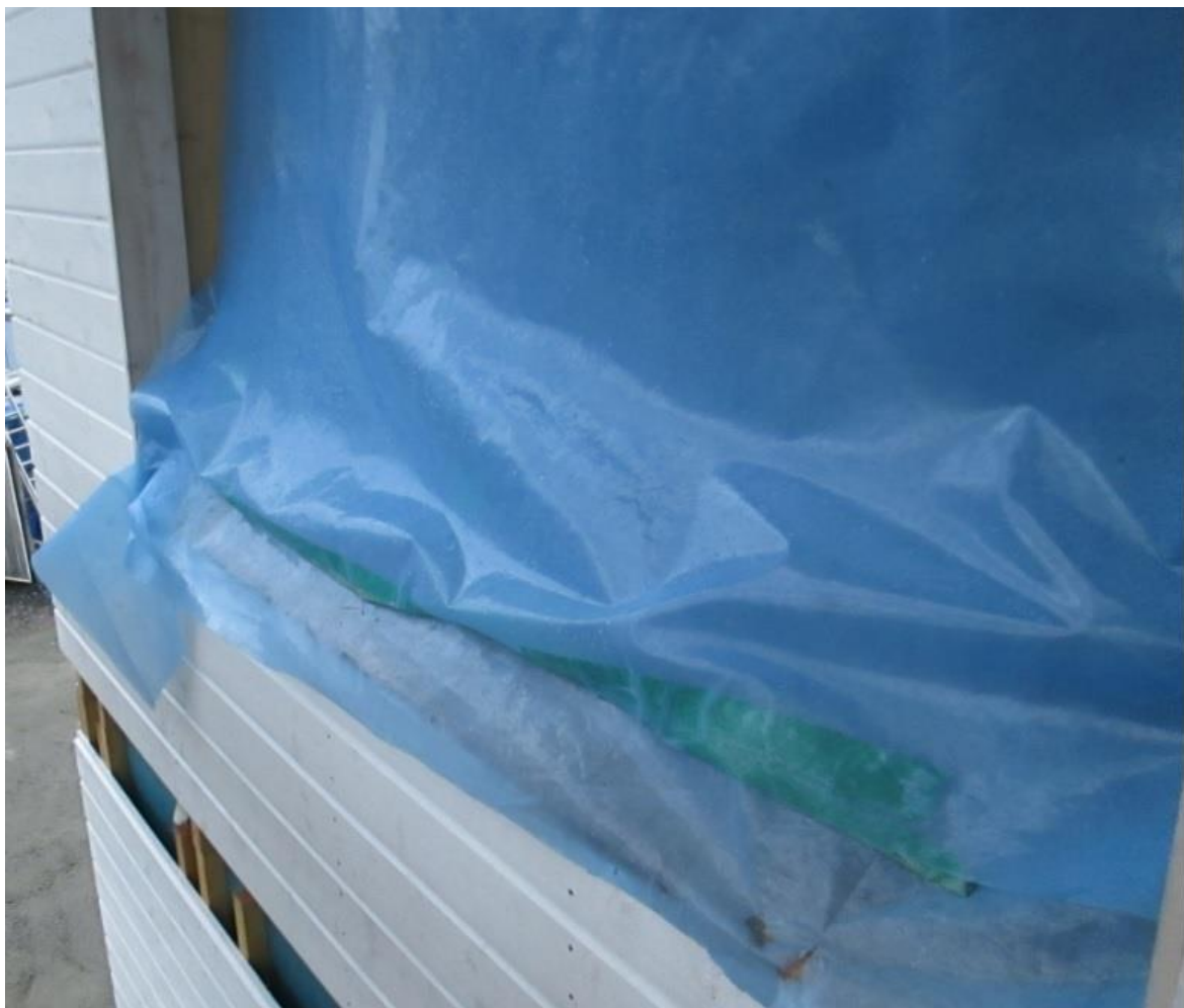
KUVA 11. Ikkuna-aukon suojaus muovilla (Hakkarainen 2015-03-10.)
