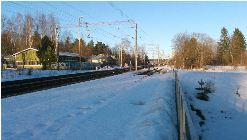
KUVA 6. Lasitehtaan sähköistämätön raide oikealla tulisi purkaa laiturin tieltä
