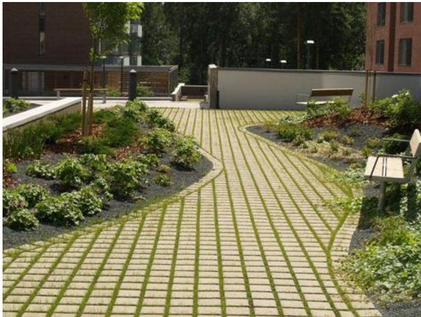
Kuva 2. Vettä läpäisevä pihakiveys (Rudus 2015: Vettä läpäisevät päällysteet hulevesien hallinnassa).
