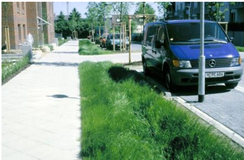
Kuva 3. Mulden-Rigole -rakenne (viittaus kuvioon 5), jossa imeytys tapahtuu suoto-ojassa (Sito 2013: Hulevesien luonnonmukainen käsittely).
