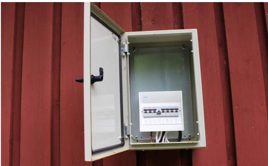
Kuva 3. Jakokeskus sisältä 16 A, johdonsuojakytkimet.
