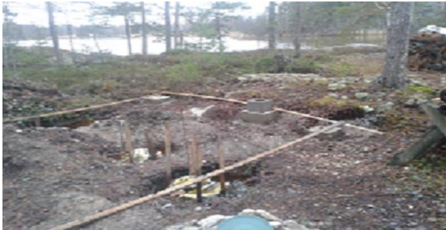
Kuva 10. Kuusi betonikulmaa valettuna.
