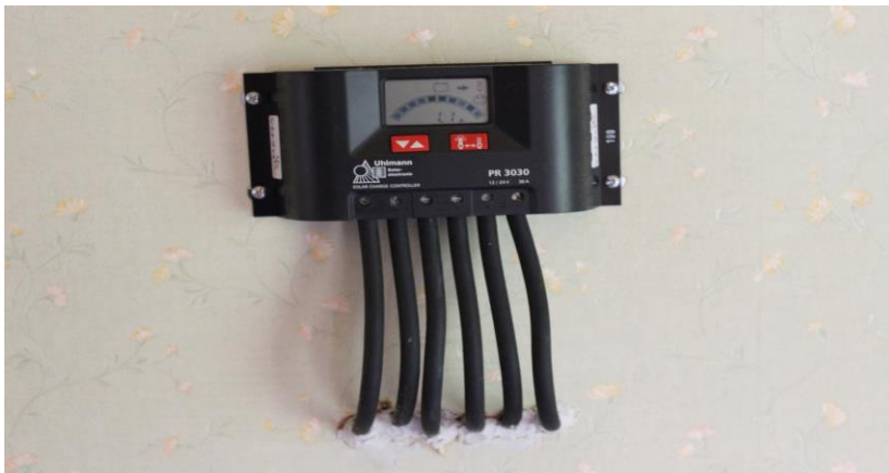
Kuva 5. Säädin PWM 30 A, mökin sisäseinällä.
