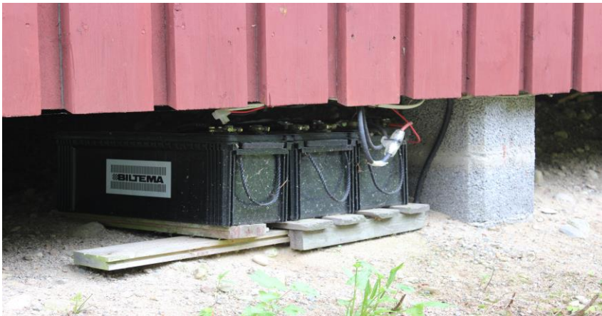
Kuva 2. Akusto 3*120 Ah, pääsulake 40A.
