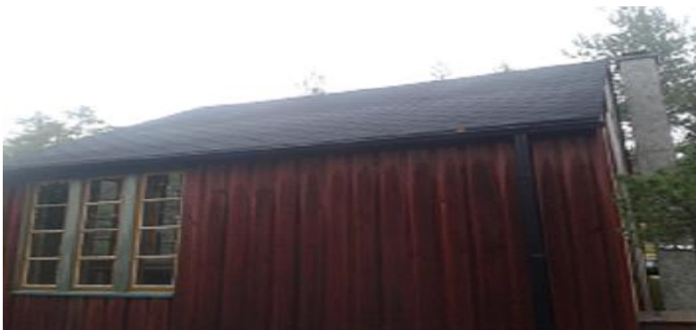
Kuva 12. Loma-asunnon katto kuvattuna siitä suunnasta, johon aurinkopaneelit tulevat sijaitsemaan.
