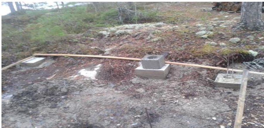
Kuva 11. Kolme betonikulmaa valettuna.
