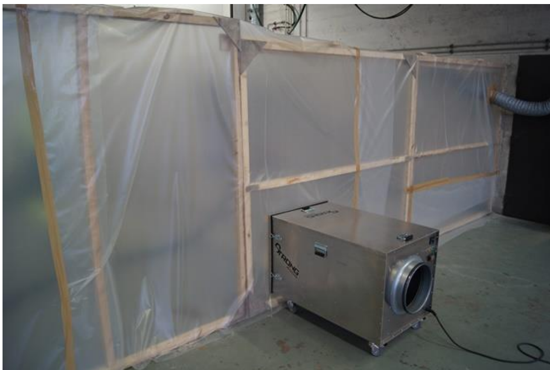
Figur 2. Undertrycksmaskin och skiljevägg. (Strong, u.å.)
