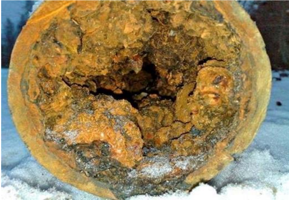
Kuva 7. Vesijohtoon kerääntynyttä sakkaa. (6, s. 7.)
