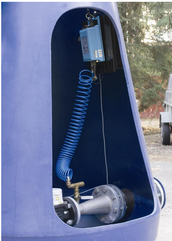
Kuva 11. Kaivossa oleva virtaamamittari. (11.)
