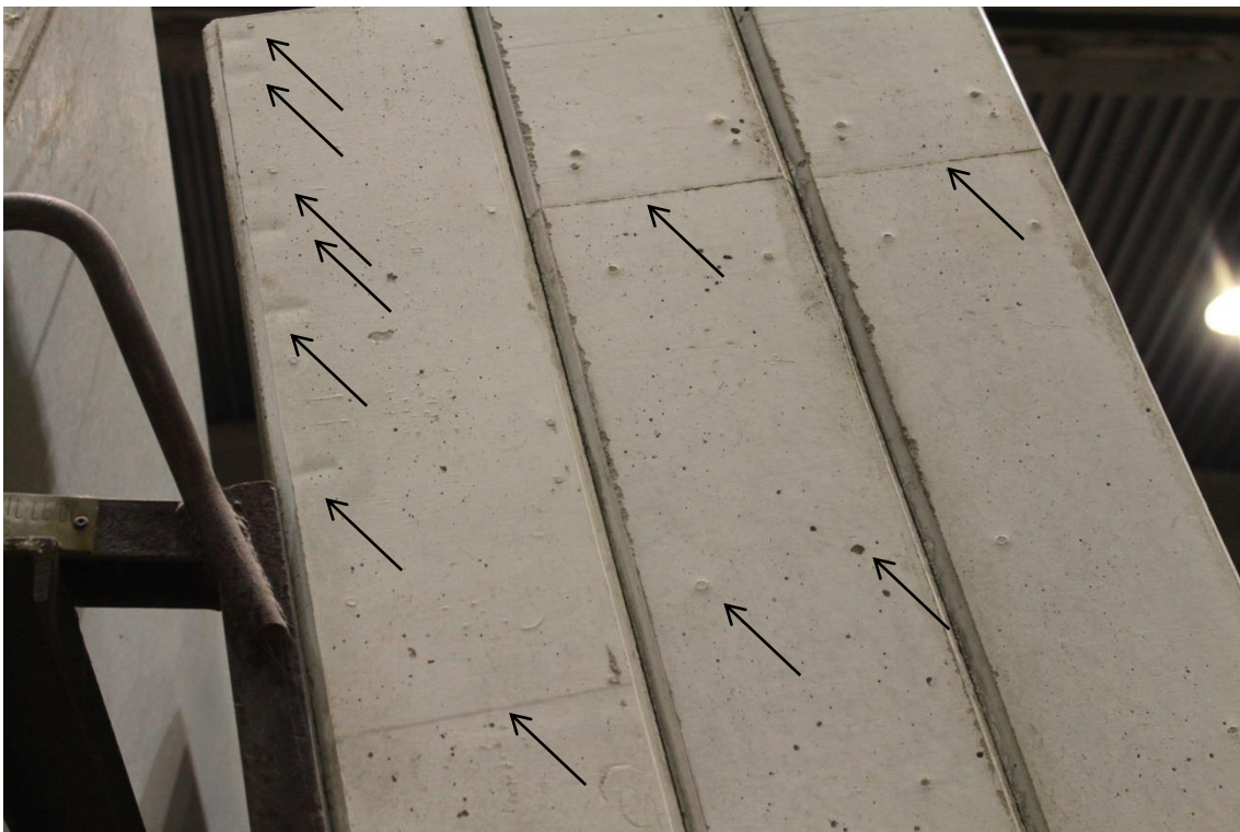
KUVA 21. Muotista aiheutuvat jäljet huonontavat huomottavasti paljaaksi jäävää betonipintaa laadultaan
