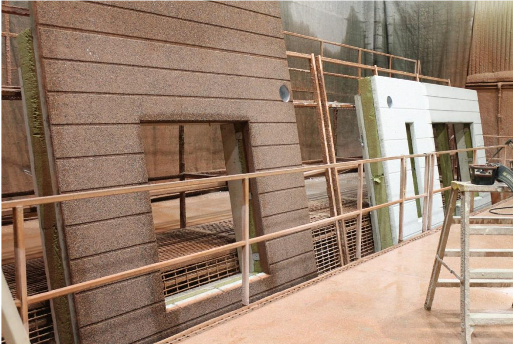
KUVA 2. Valmiita rouhebetonipintaisia elementtejä pesurekissä
