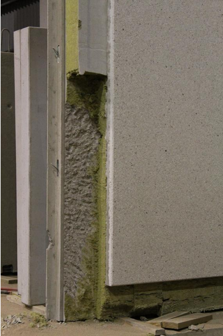
KUVA 7. Liian paksun sisäkuoren aiheuttamaa epätyydyttävää laatua ja korjaustoimenpiteitä
