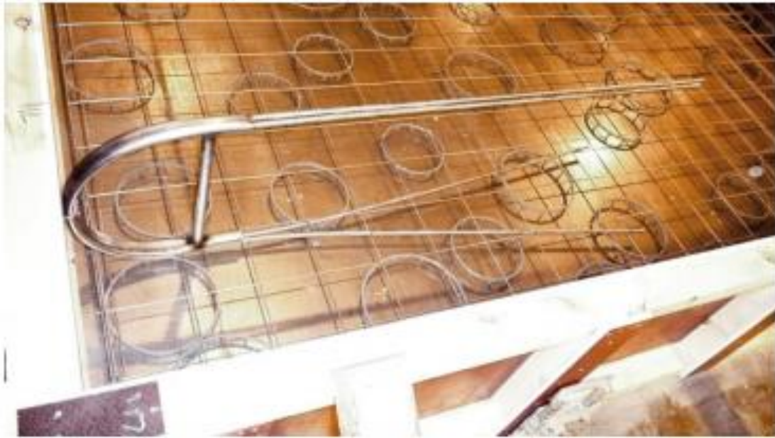
Kuva 5 PNLF nostolenkin asentaminen muottiin
