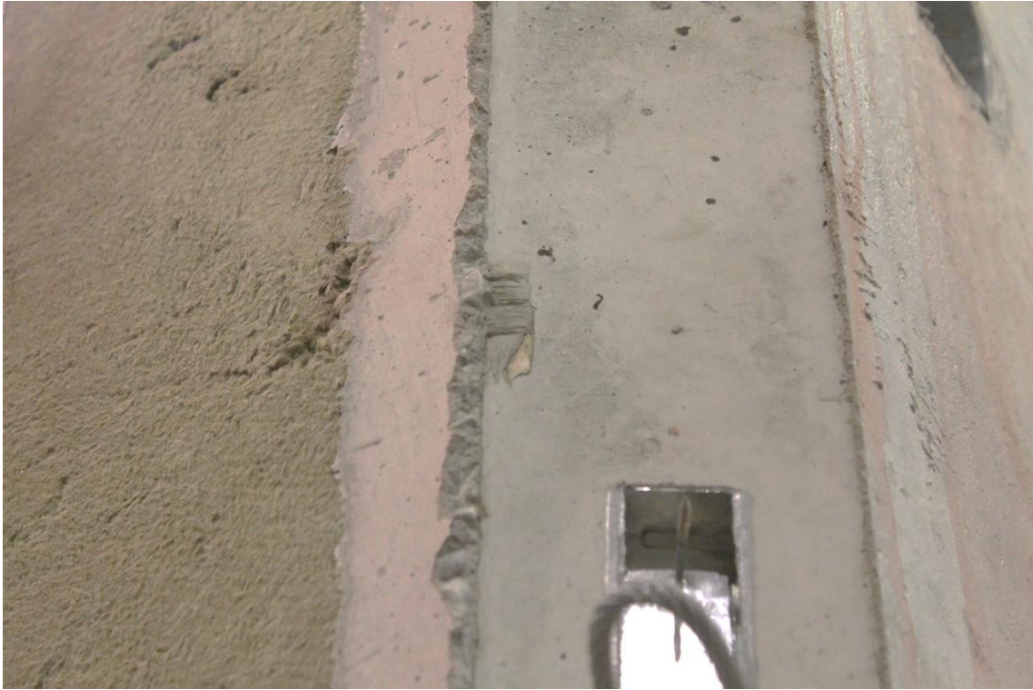
KUVA 5. Betoniin jäänyt muottivanerin palanen
