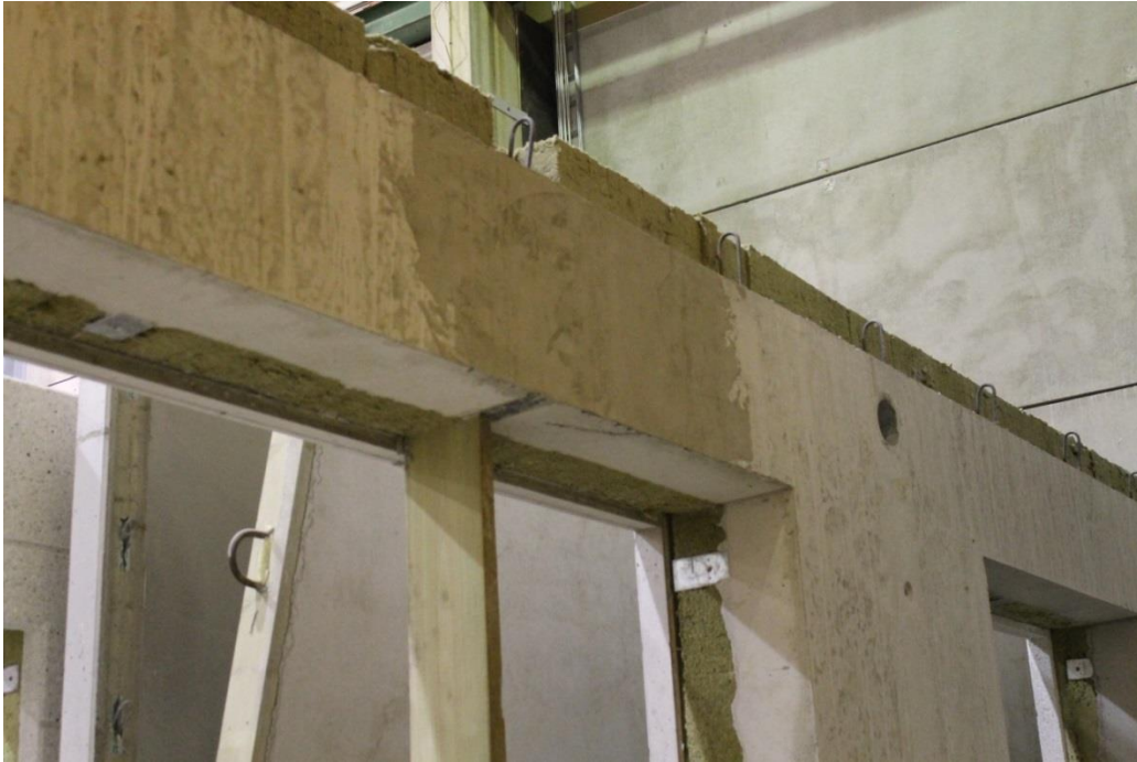
KUVA 20. Lohjennut nostolenkin kohta, joka on jälkeempään korjattu
