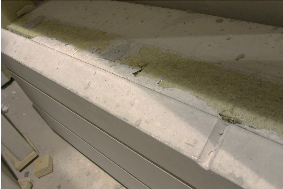
KUVA 6. Betonivalun aikana ikkuna-aukon tuuletusura on täyttynyt betonilla, joka tulee poistaa
