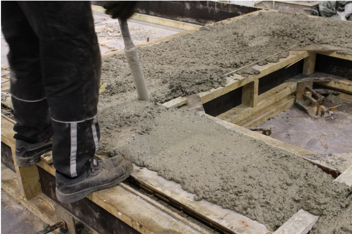
KUVA 39. Betonin tiivistystä sauvatäryttimellä
