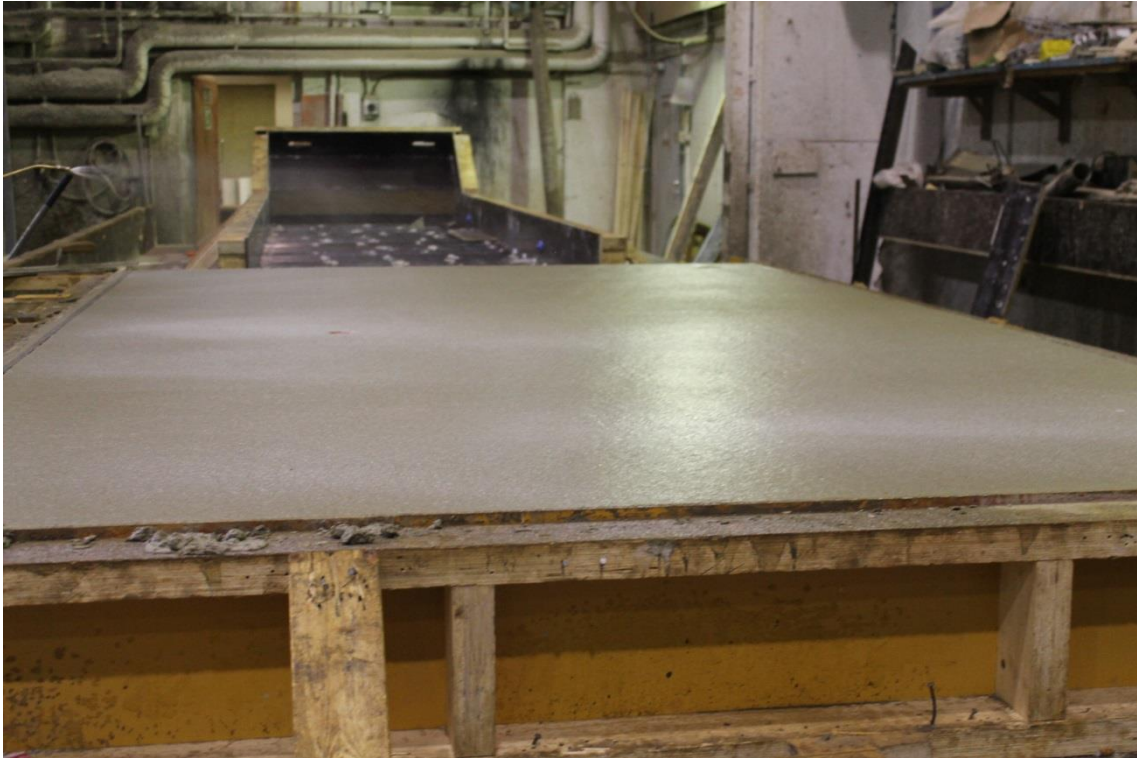
KUVA 48. Valmiin parveke-elementin pinnan jälkihoitoa
