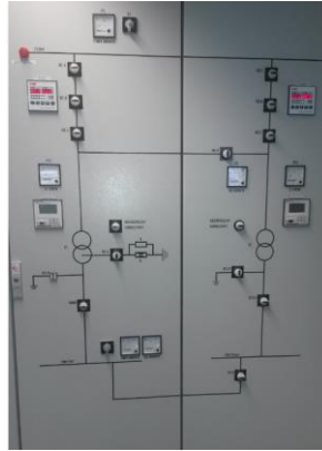
Kuva 28. Demolaitteiston muuntajakentät
