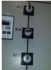
Kuva 60. Muuntajan verkosta erottava katkaisija.
