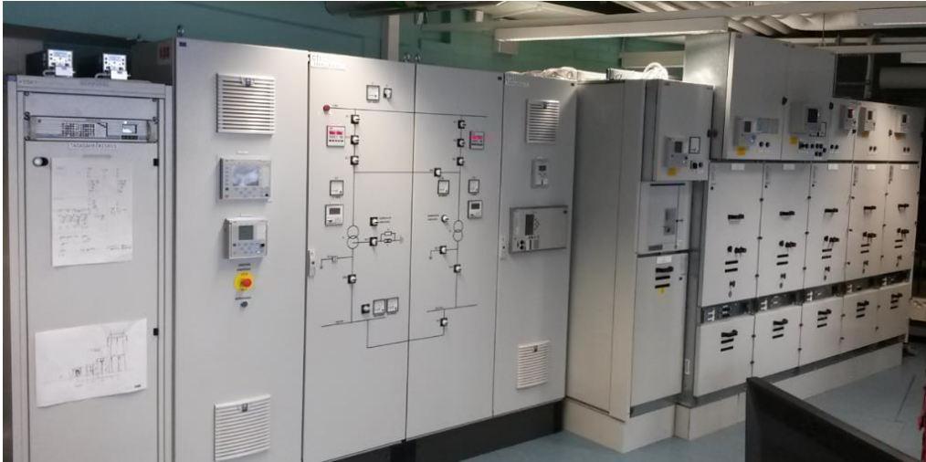
Kuva 27. Demolaitteisto ja 10 kV kojeisto
