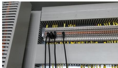
Kuva 40. Riviliittimelle tulevat johdot
