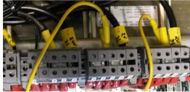
Kuva 64. Vikavastuksen kytkentä muuntajaan
