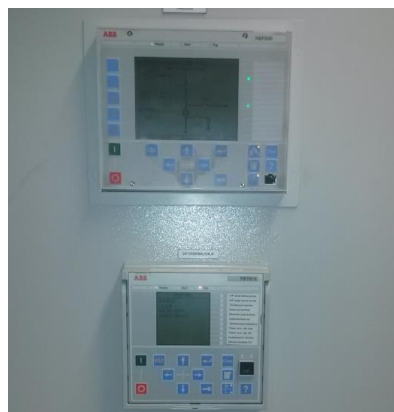
Kuva 29. Demolaitteiston ABB:n monitoimireleet
