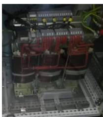
Kuva 63. Trafotek Oy:n valmistama kolmivaihemuuntaja.
