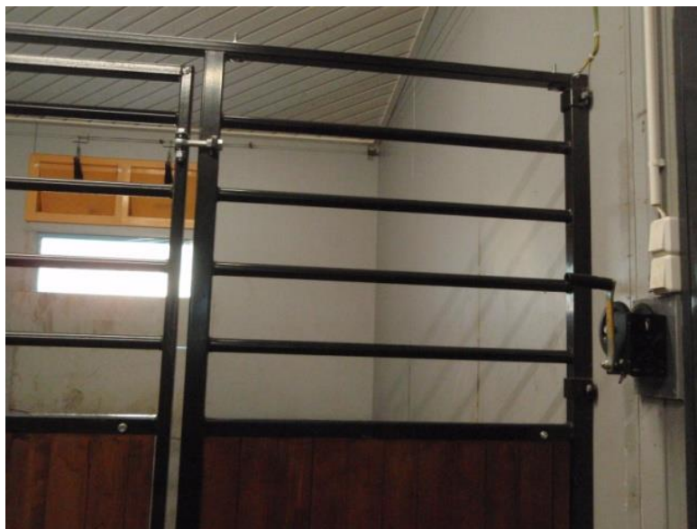
Kuva 30. Tuloilmanaukkojen säätäminen onnistuu seinässä olevan kammien avulla. (Hyvönen 2013.)
