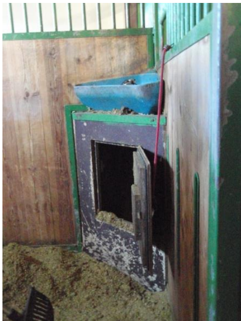
Kuva 16. Kottikärryjen kuljetukselta säästytään karsinan kulmaukseen valmistetun lantojen tyhjenyslukuun ansiosta. (Hyvönen 2014.)
