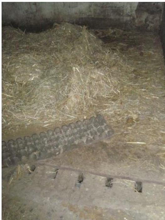
Kuva 22. Kumimatto päästää virtsan valumaan lävitseen alla oleviin kuiluihin. (Hyvönen 2014.)
