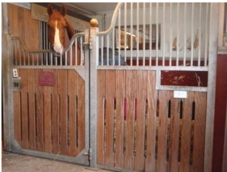
Kuva 29. Ilmanvaihtoaukot karsinan seinissä parantavat karsinan ilmanlaatua. (Hyvönen 2014.)
