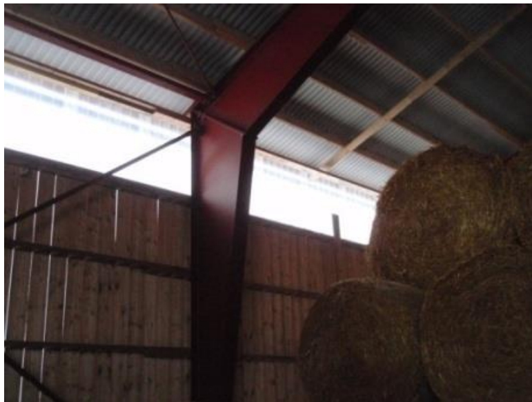
Kuva 33. Valokatetta voidaan hyödyntää varastotiloissa valoisuuden parantamiseksi. (Hyvönen 2013.)
