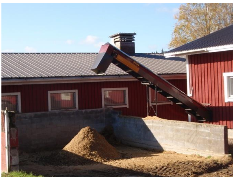
Kuva 19. Tallin sisältä lantalaan johdettu lantakuljetin. (Hyvönen 2014.)
