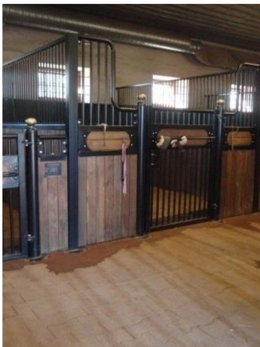
Kuva 23. Käytävien kumimatot vähentävät liikkumisesta aiheutuvaa meteliä. (Hyvönen 2014.)
