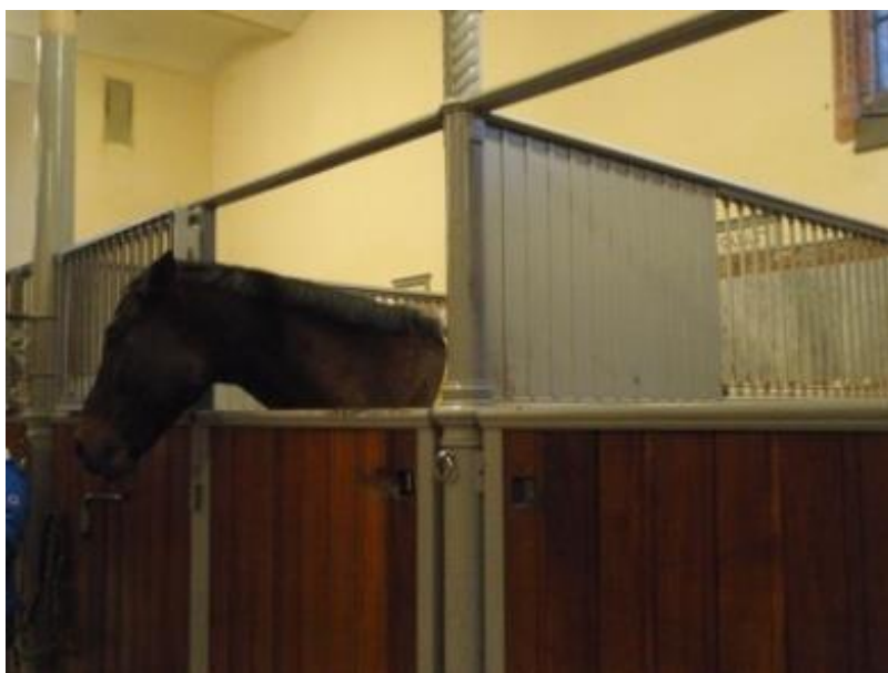
Kuva 34. Osittain peitetty väliseinä karsinoiden välillä tuo hevosille omaa rauhaa, mutta mahdollistaa myös toisten hevosten kanssa seurustelun. (Hyvönen 2013.)
