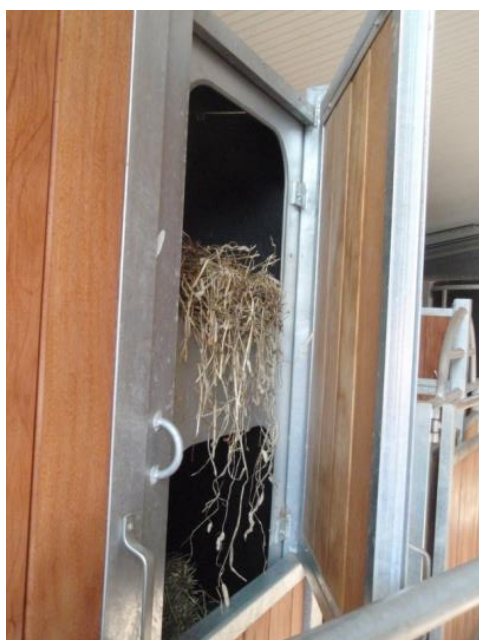
Kuva 10. Käytävälle avautuva heinäautomaatin täyttöaukko. (Hyvönen, K. 2014.)
