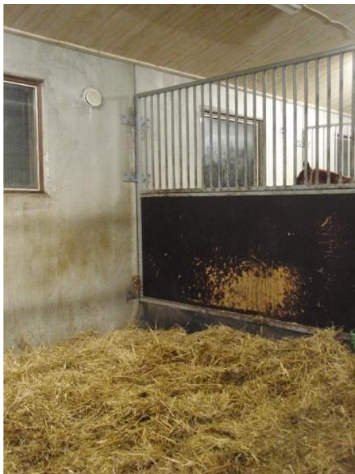
Kuva 20. Kumimatto karsinan väliseinän alapuolella mahdollistaa väliseinien liikuttamisen silloinkin, kun kuivikekerros on noussut jo korkeammalle. (Hyvönen 2013.)
