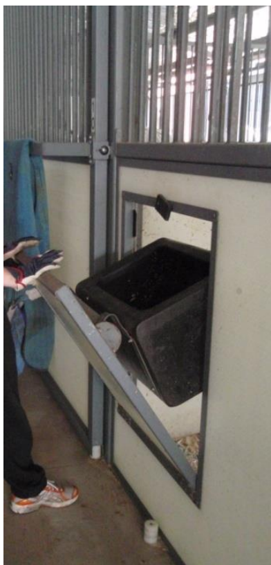
Kuva 8. Työntekijöiden turvallisuus paranee ja työaikaa säästyy kun hevosten ruokinta voidaan toteuttaa menemättä hevosen karsinaan. Kuvassa käännettävä seinä irrotettavaa ruokakuppia varten. (Hyvönen 2012.)
