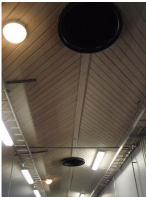
Kuva 31. Painovoimaisen ilmanvaihdon poistoilmanhormit tallissa. (Hyvönen 2013.)
