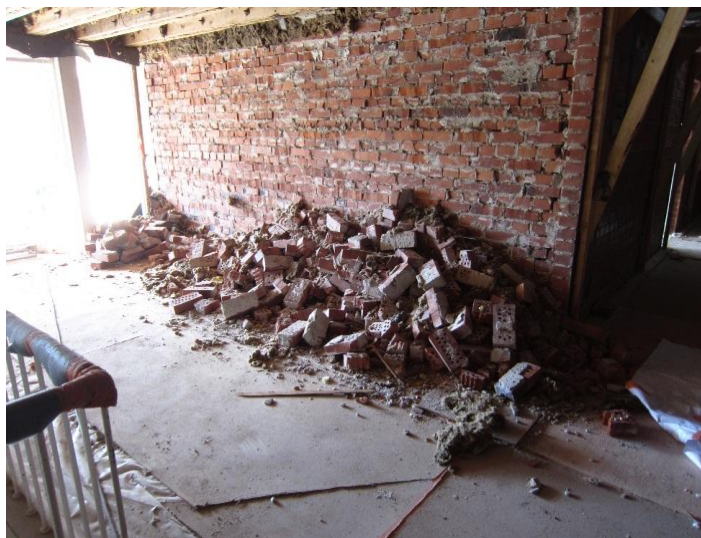
Kuva 8. Puretun tiiliseinän jätteet siivoamatta.
