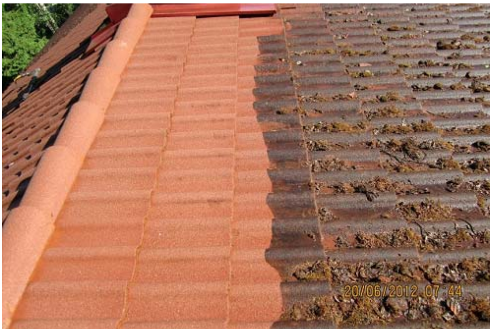
KUVIO 9. Tiilikaton pesu ennen maalausta.
