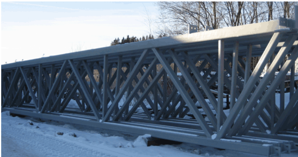
KUVIO 8. . Korroosionesto suojamaalattuja metallisia kattoristikoita.
