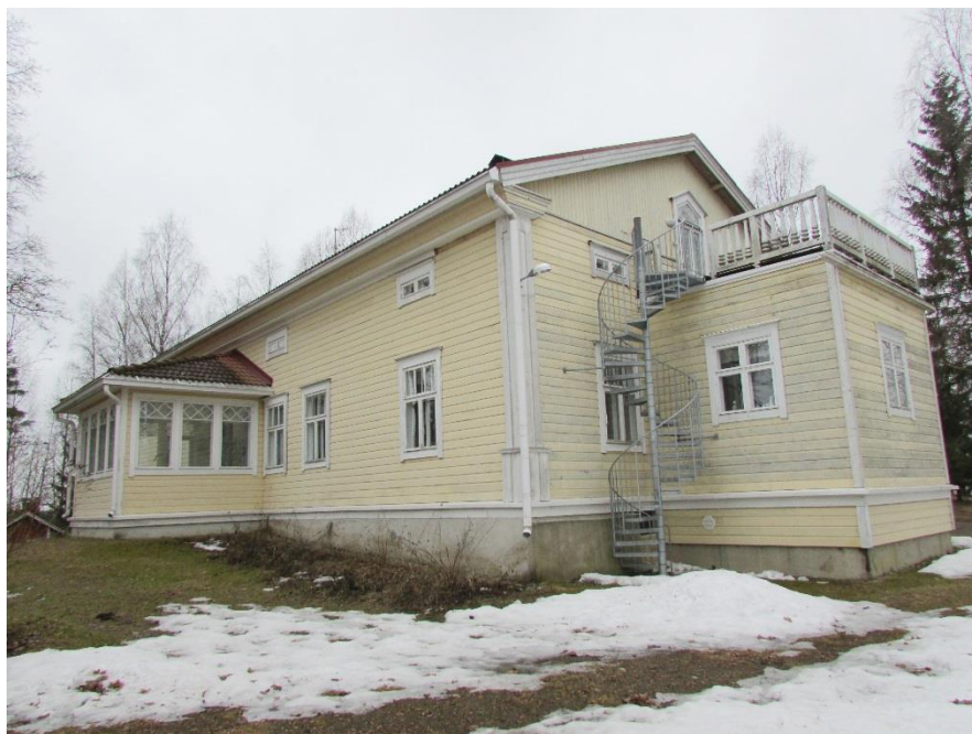
Kuva 2. Kaukalinnan luoteispääty ja koillispuoli. (Nousiainen K. 7.4.2015)
