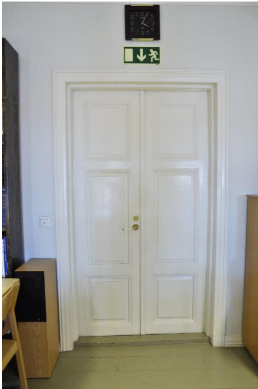
Kuva 4. Kolmipeilinen pariovi salista eteiseen.
