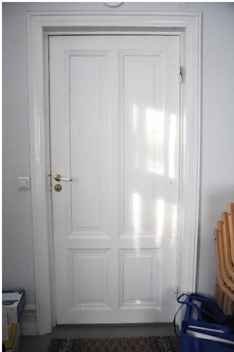
Kuva 1. Nelipeilinen piispanhuoneen ovi.
