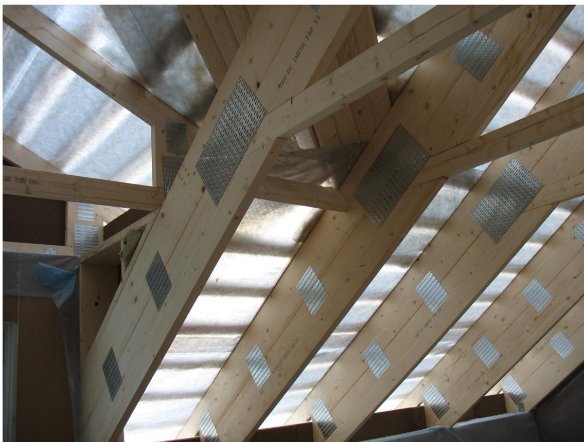
Figur 19. Här syns de bärande balkar som isoleringen placeras emellan, så att en luftspalt lämnas utanpå isoleringen, dock kommer stödet som syns mellan huvudbärarna i detta fall att stoppa luftflödet mellan takfot och takås (Rakennus26 2012)
