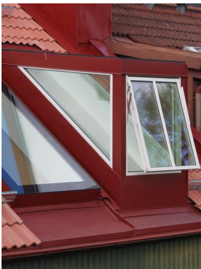
Figur 6. Taklykta beställd som element av aluminium och glas (Attic Group AB u. å., s. 1)
