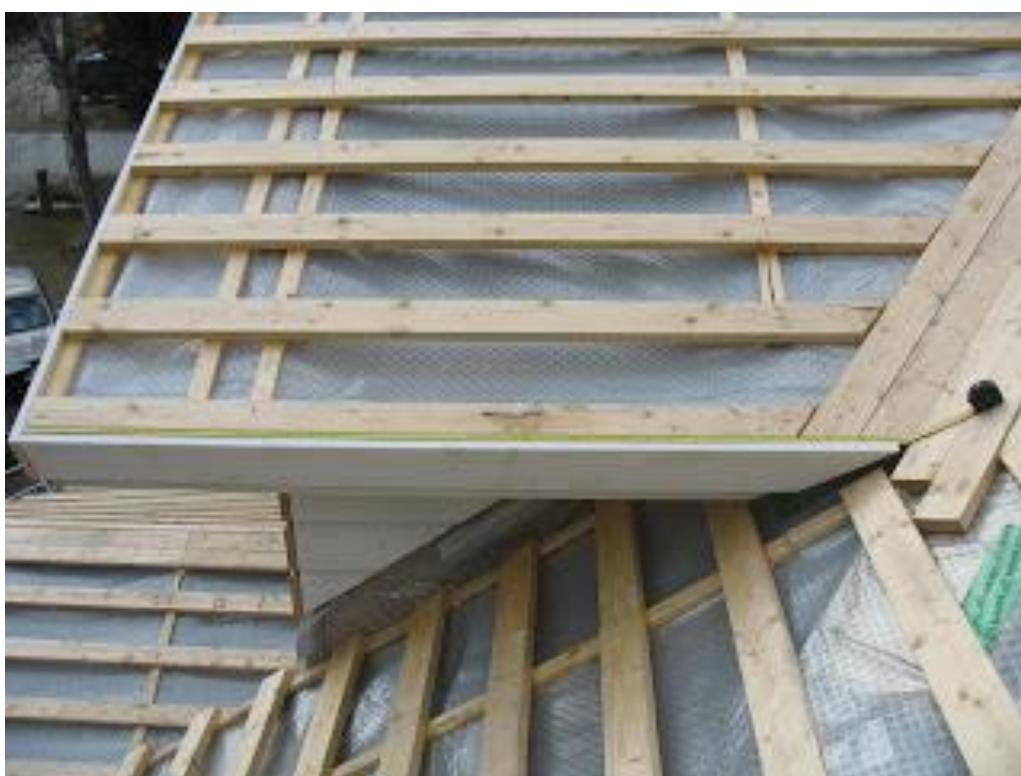
Figur 20. Lösning av vattnets avledning vid giren (Rakennus26 2012)
