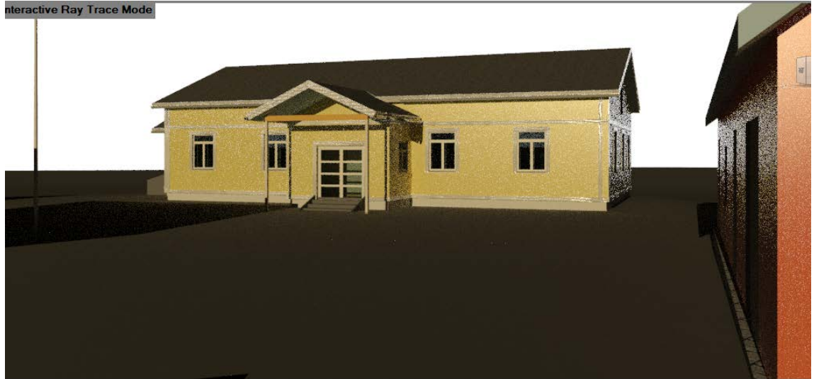
Kuva 6. Kohde pihaan tullessa (Maapuro 2015)
