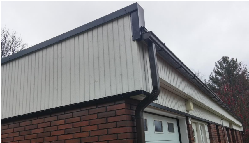
Kuva 16 Rakennuksen nykyiset räystäät
