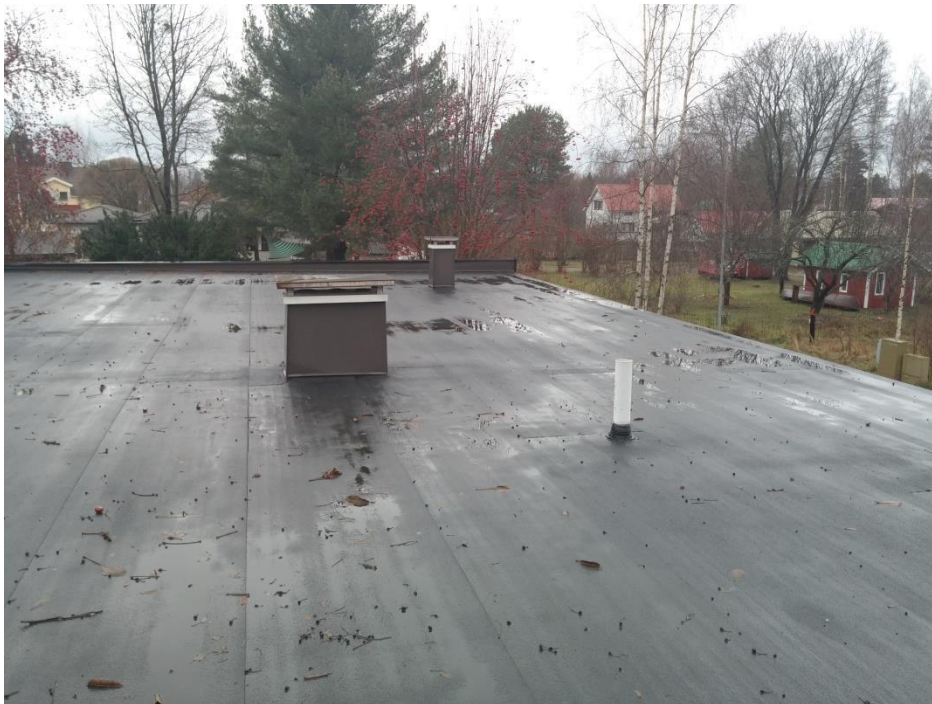
KUVA 19 Vettä kerääviä lammikoita katolla
