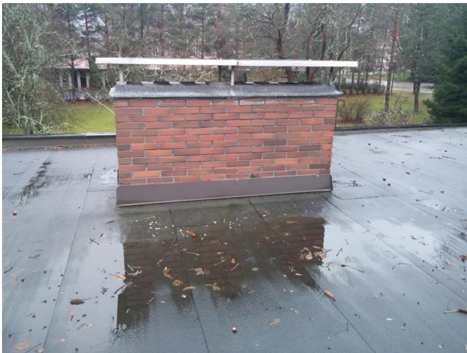
KUVA 5 Vettä keräävä painuma hormin vieressä
