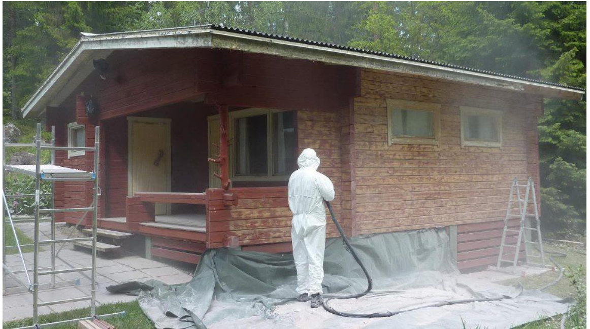
Kuva 19. Hirsirakennuksen julkisivupinnoitteen soodapuhallus [36].
