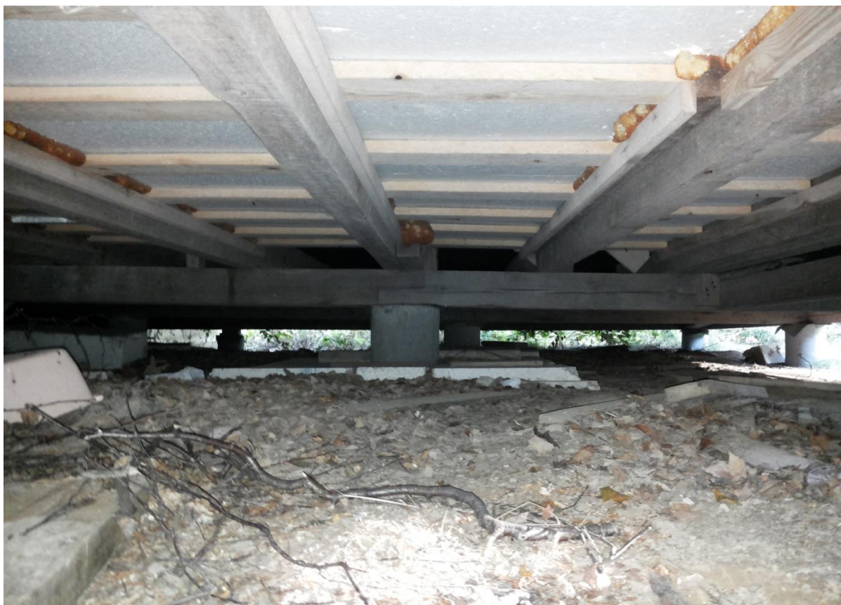
Kuva 4. Osa alapojasta on lämpöeristetty eps-eristeellä.
