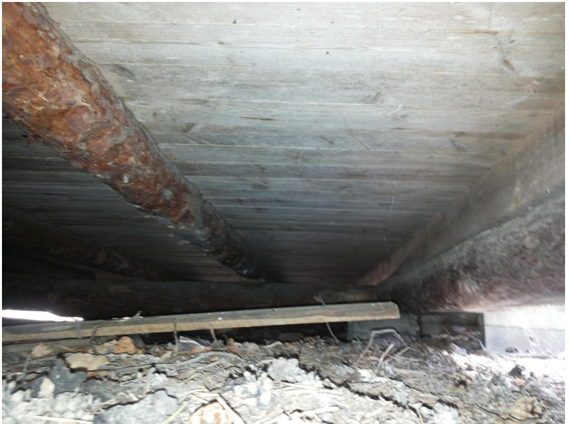
Kuva 6. Lattiavasat kuorimattomasta tukista.
