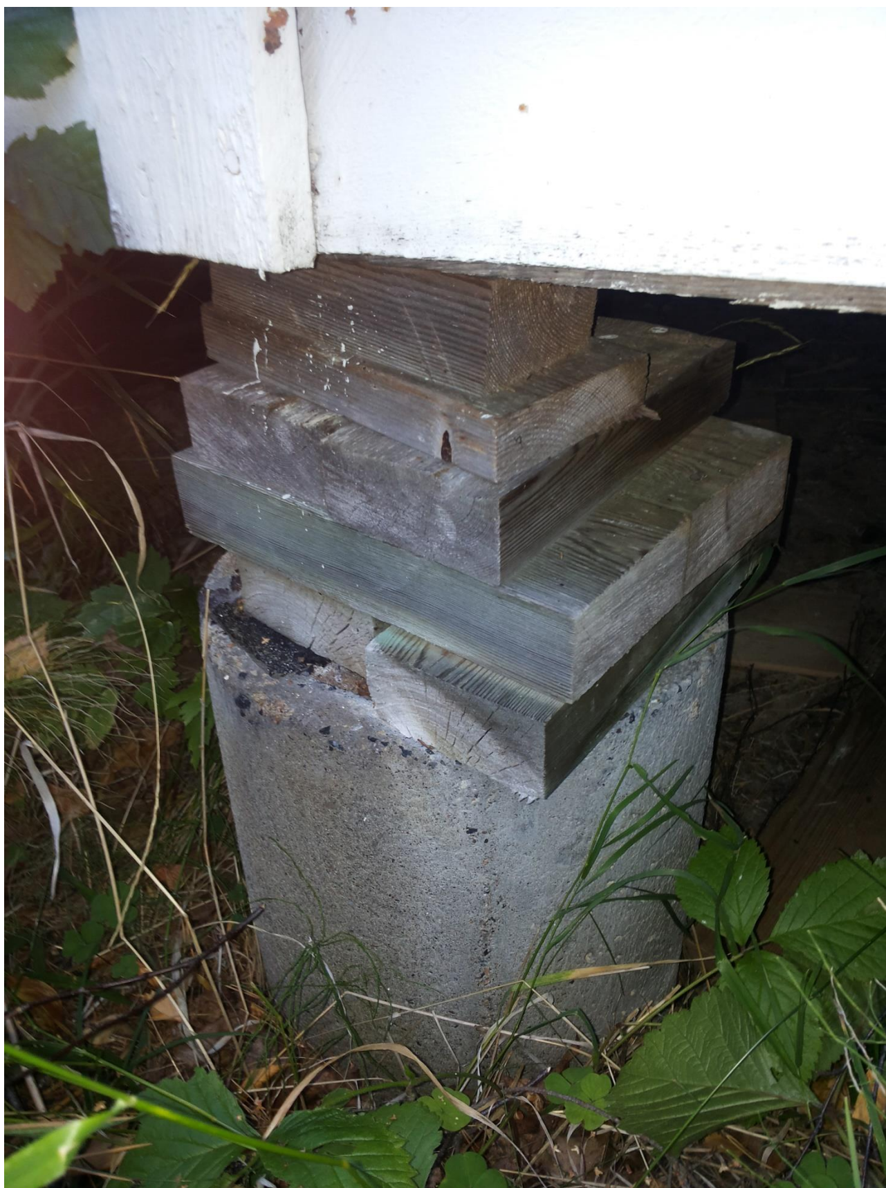
Kuva 1. Routimisen vaikutuksia on pyritty korjaamaan puupalikoilla.
