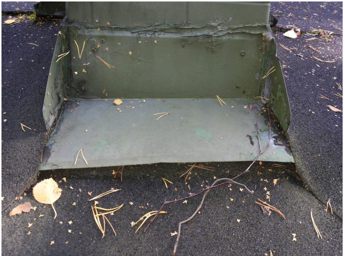
Kuva 14. Hirren painumisesta johtuva piipunpellityksen irtoaminen alustastaan.
