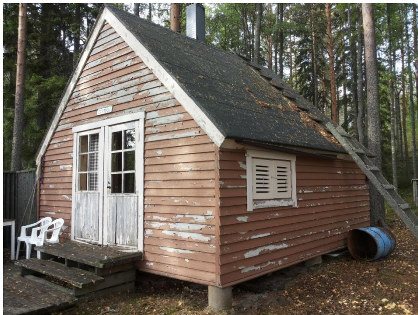
Kuva 8. Peruskorjatun lautamökin julkisivu
