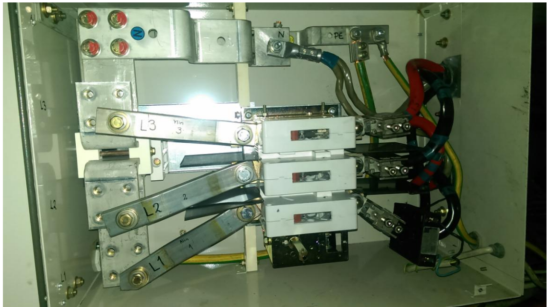
KUVA 9. Mittauspiste voimansiirtolinjalla
