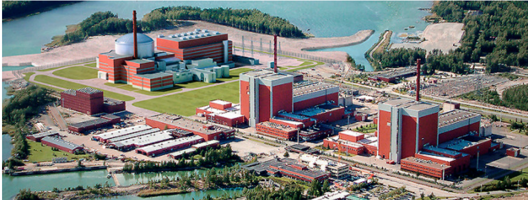
Kuva 1. Kuvassa oikealla on Olkiluodon nykyiset laitoseskiköt OL1 ja OL2 ja vasemmalla tulevaisuudessa valmistuva kolmas laitoseskikkö OL3 /10/
