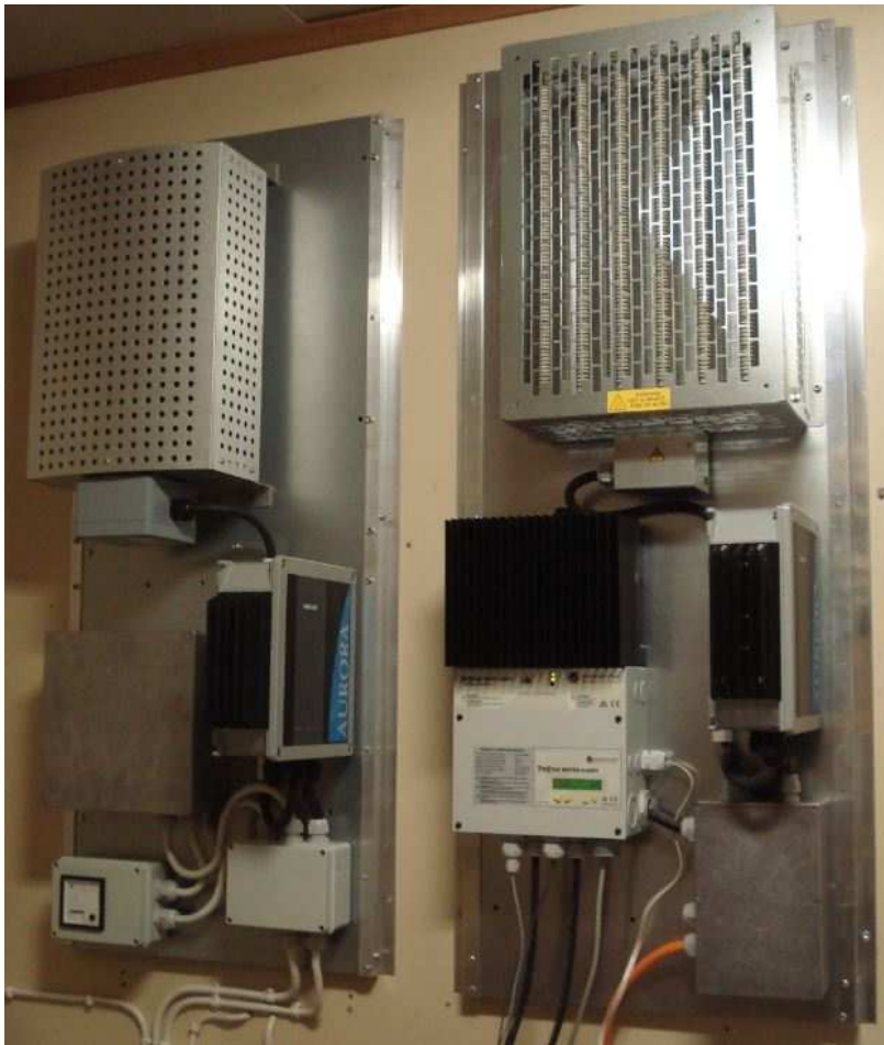
KUVA 9. Vasemmalla Tuule H200 -ja oikealla Tuule C200 -pientuulivoimalan laitteistopaneelit (Finnwind. 2014.)
