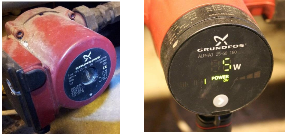
Kuva 9. Vanha ja uusi kiertovesipumppu
