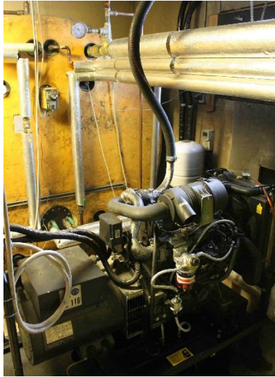
Kuva 6. Diesel-aggregaatti ja lämmivesivaraaja
