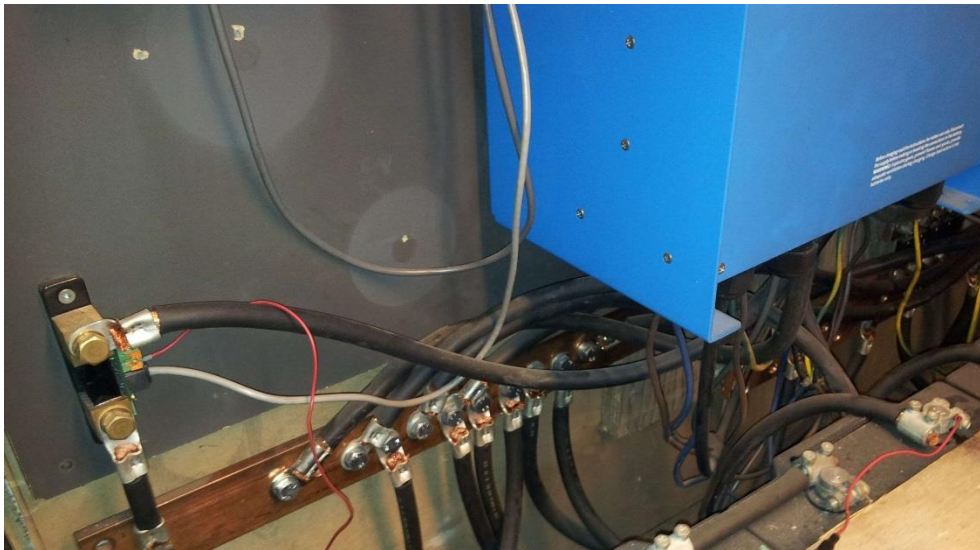
Kuva 10. Mittaavan shuntin (vasemmalla) alkuperäinen asennuspaikka
