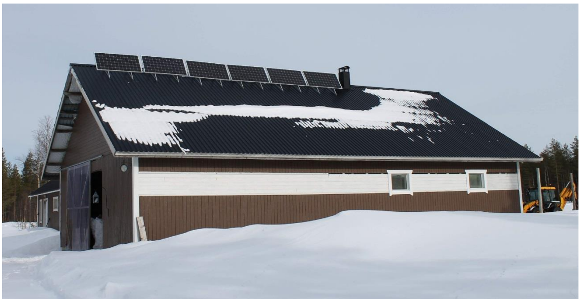
Kuva 3. Aurinkopaneelit tallin katolla
