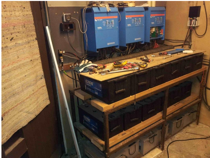
Kuva 7. Inverterit ja alkuperäiset akut
