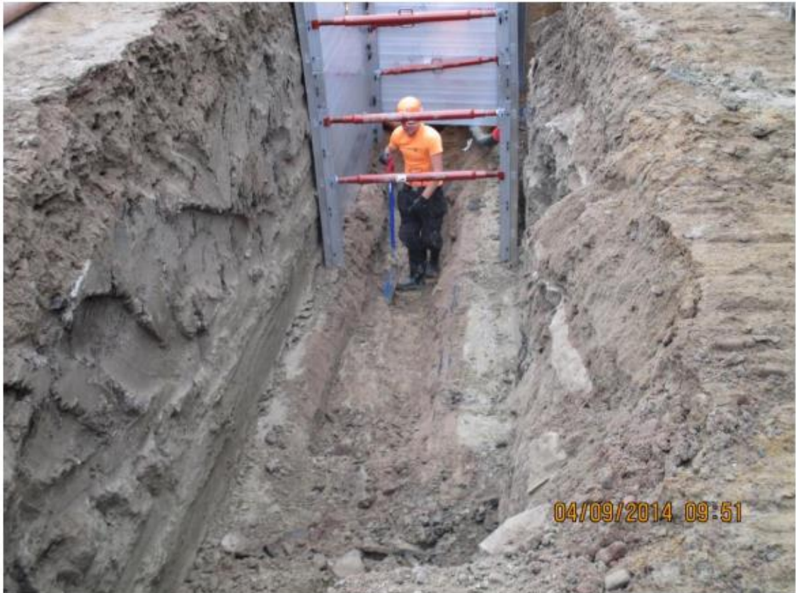
Kuva 7. Kaivantotukien asennus kaivantoon [7.]
