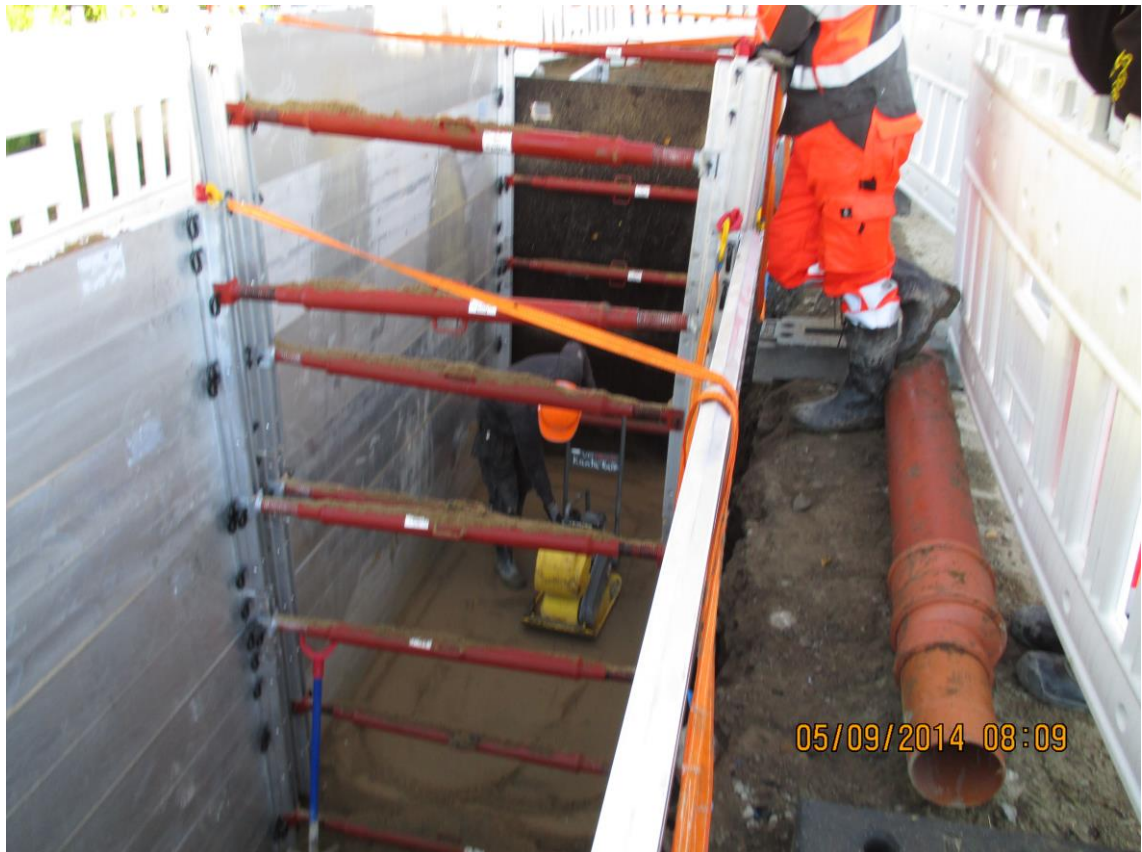
Kuva 9. Alkutäytön tiivistystä putkijohtokaivannossa [7.]
