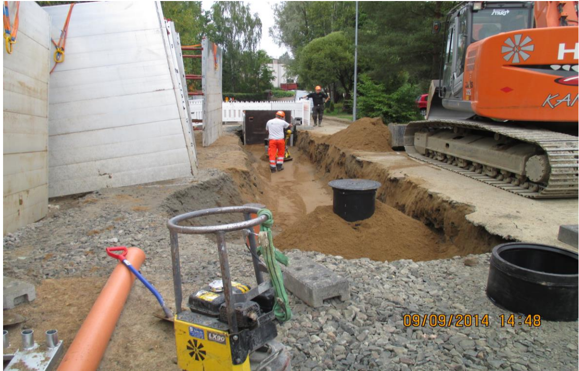
Kuva 10. Lopputäytön tekoa putkijohtokaivantoon [7.]
