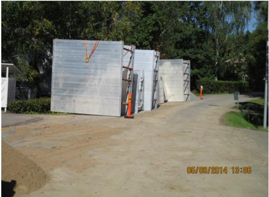
Kuva 17. Elementtiseinätukia varastoituna vesihuoltosaneeraustyömaalla [7.]
