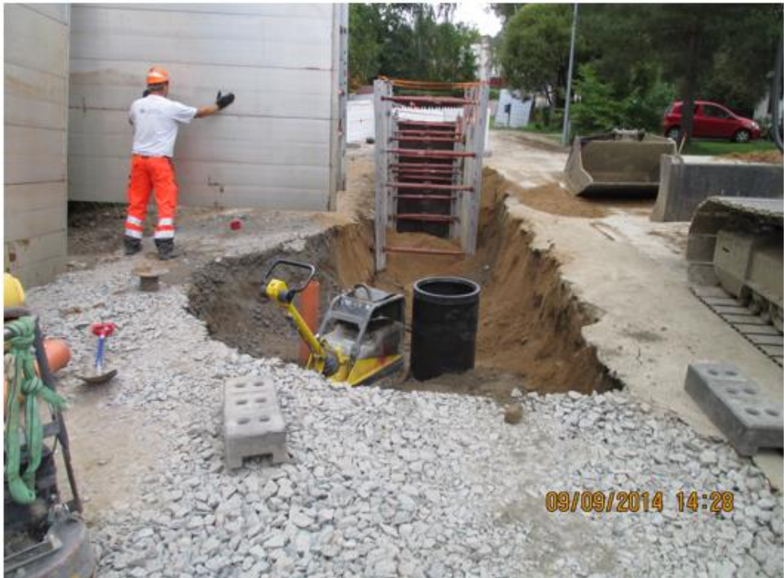
Kuva 5. Alumiinisen elementtiseinätuen siirto kaivinkoneella [7.]
