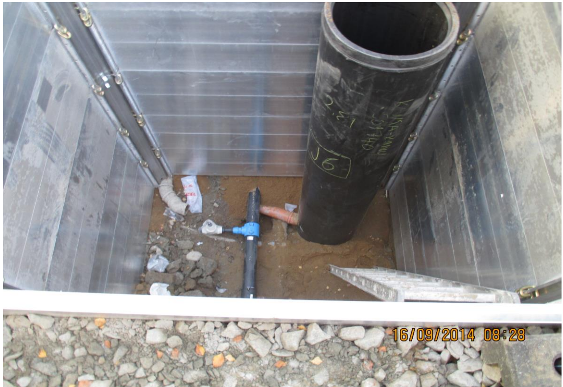
Kuva 11. Elementtiseinälaatikkotuki tonttijohtosulun ja kaivon kohdalla [7.]
