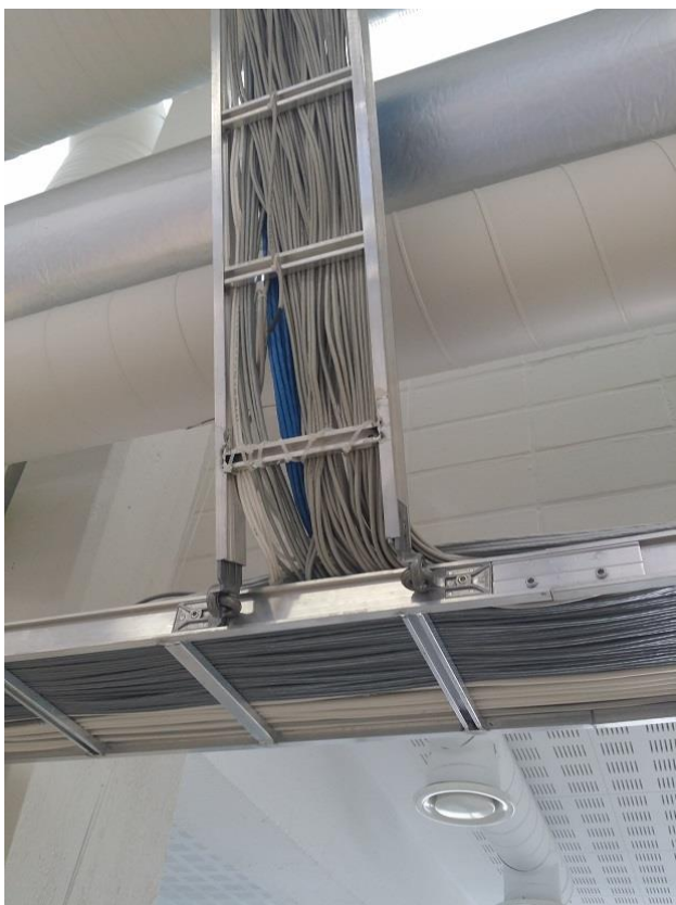
Kuva 12. Fysiikan laboratorion kaapelihylly
