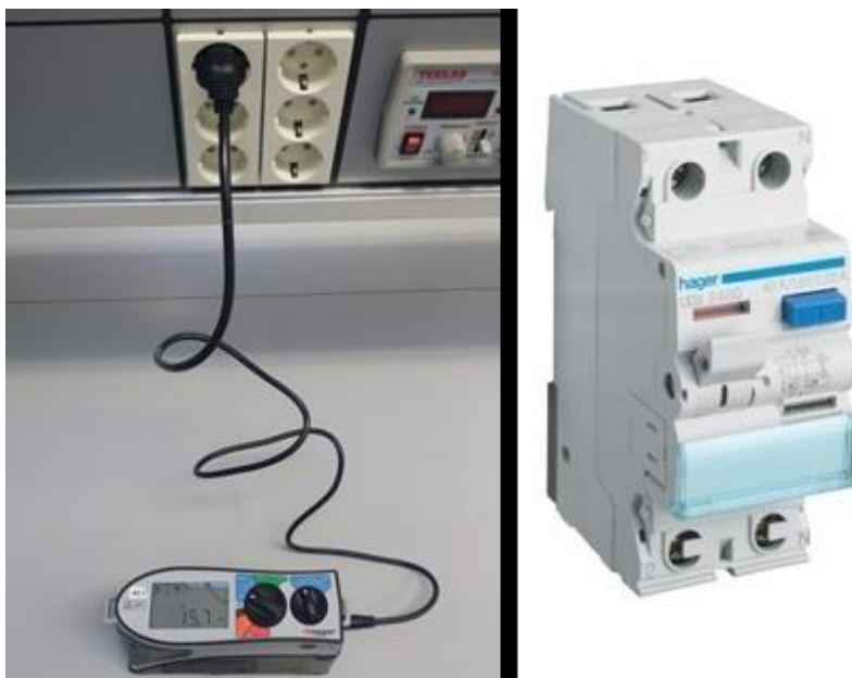
Kuva 5. vikavirtasuojakytkimen toiminta-ajan mittaus ja vikavirtasuojakytkin
