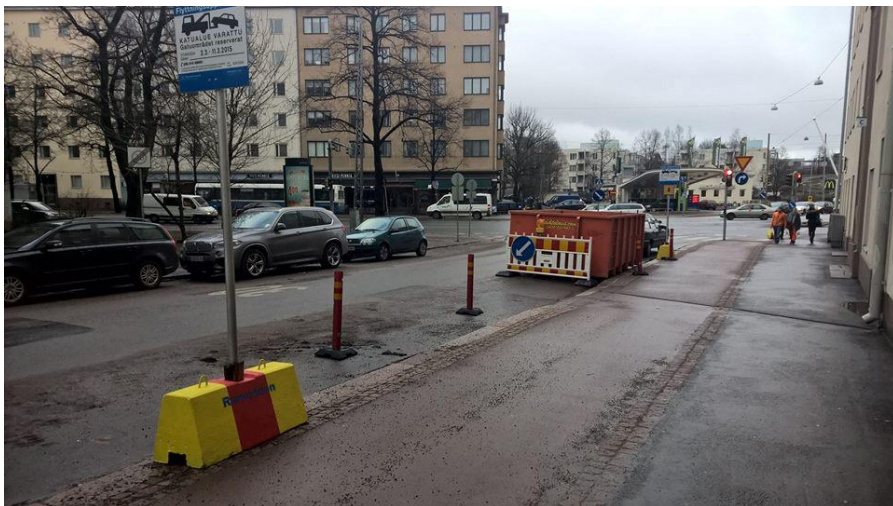
Kuva 1: Vaihtolavan aikaiset liikennejärjestelyt, Stenbäckinkatu Helsinki
