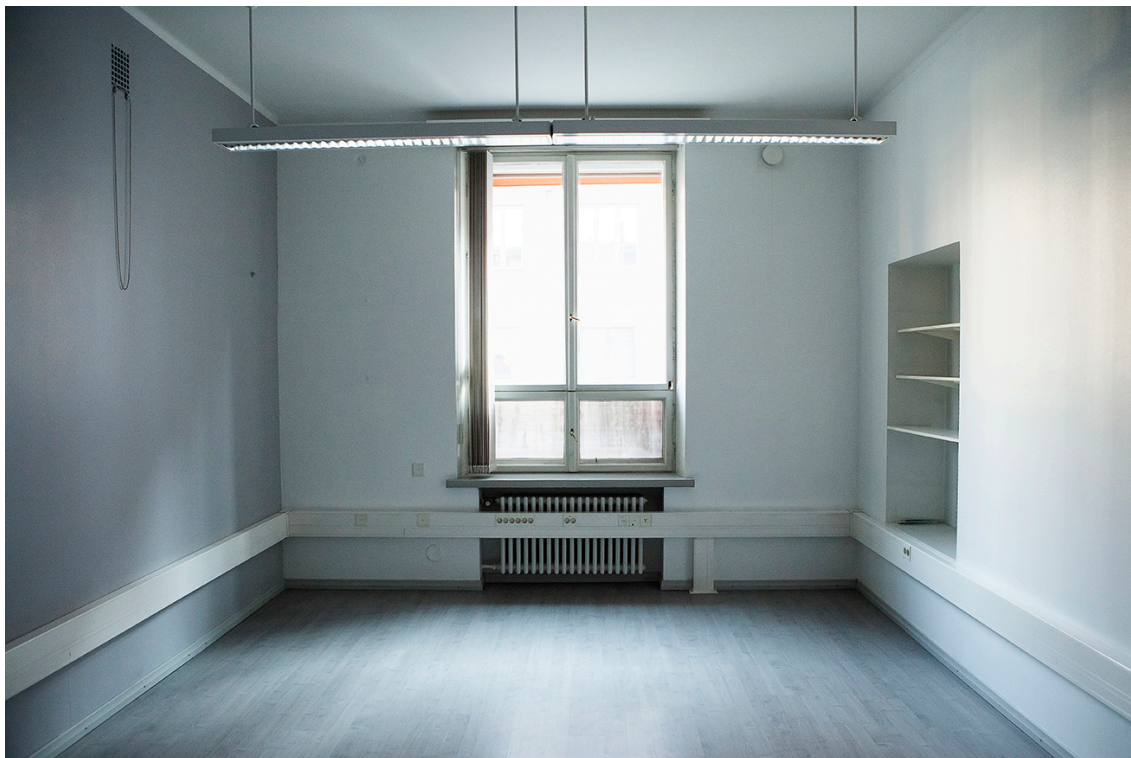
Kuvio 7. Päästudio ennen remonttia. Oikean- ja vasemmanpuoleisiin seiniin tullaan tekemään reiät. Lattialle tulee kokolattiamatto, kattoon ja seinille akustopaneelit. (Mitro Härkönen 2014.)
