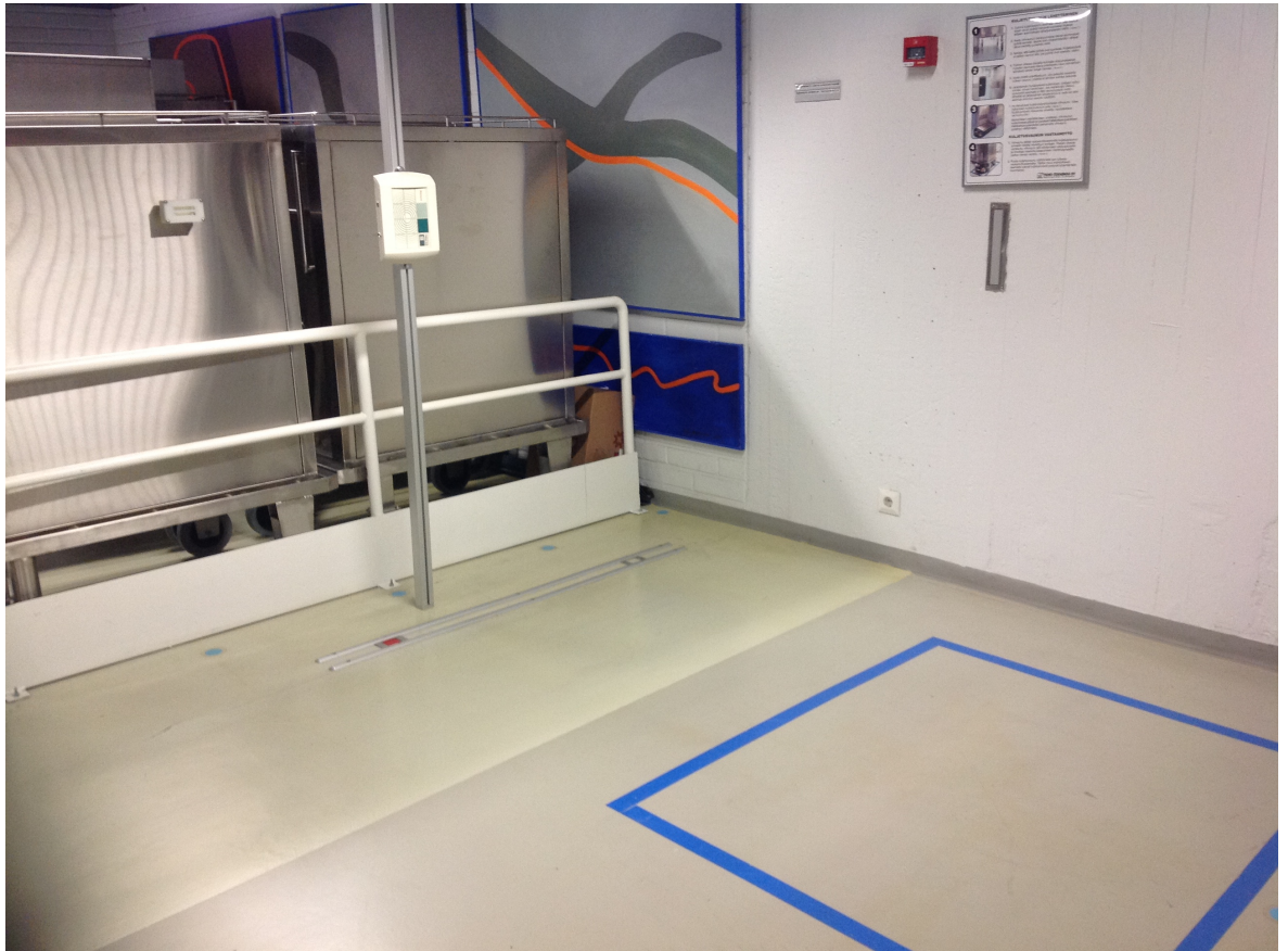
Kuvio 21. Kuvassa lähetysasema ja vastaanottoasema, sinisellä rajattu alue on vastaanottoaseman alue.
