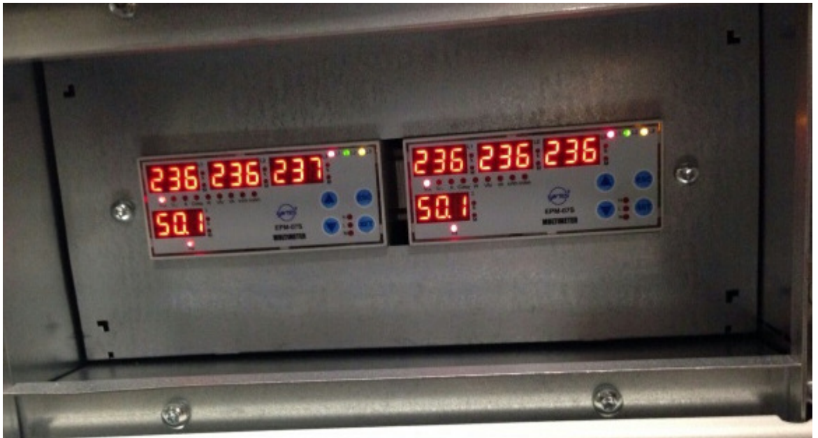
Kuva 14. Keskukseen asennetut verkkoanalysaattorit
