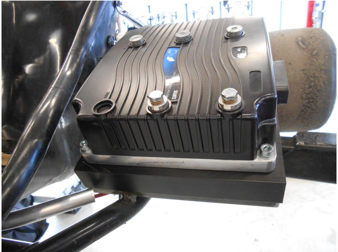
KUVA 4. Moottorinohjain asennettuna penkin vierelle
