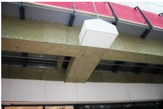
Teräksen palosuojaus mineraalivillalla
