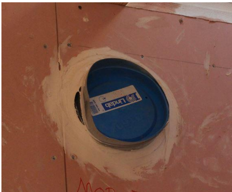
KUVA 8. Vaurioitunut palokatko (Malinen 2014-09-30)
