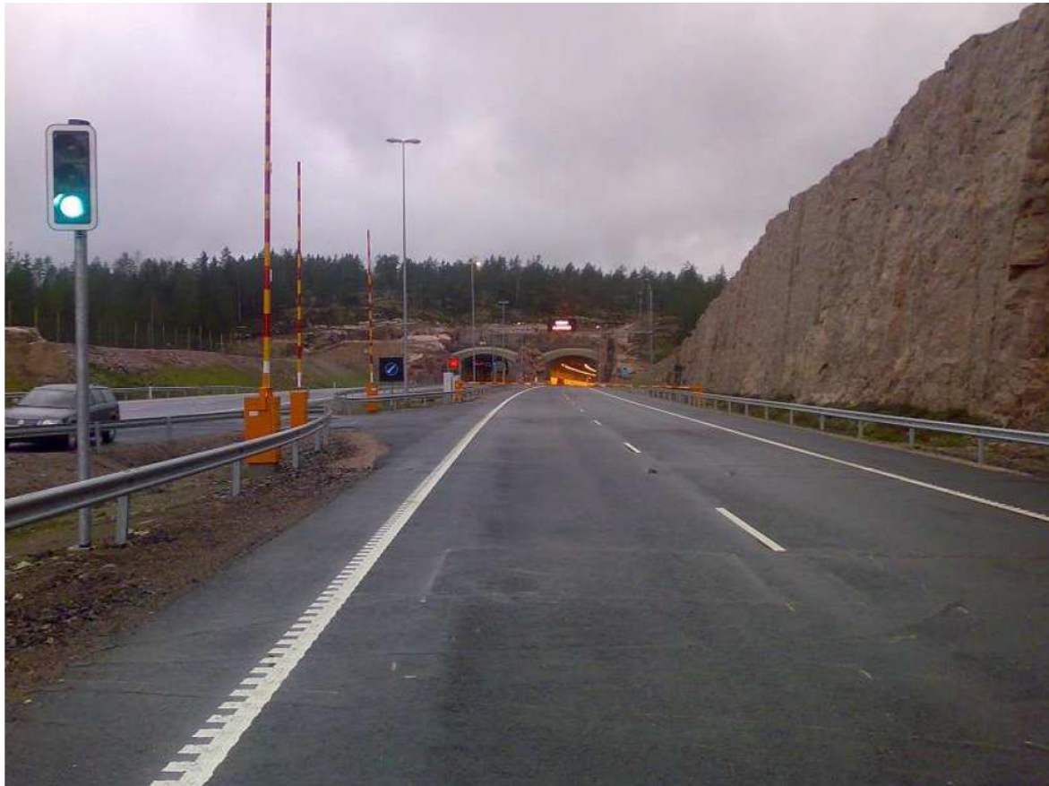
Kuva 6. Telematiikkalaitteita E18 Muurla-Lohja – moottoritieosuudella (Reini, A. 2015)
