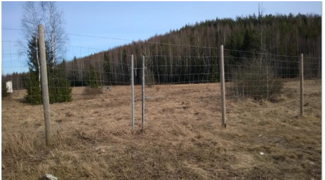
Kuva 21. Riista-aidan huoltoportti. Huoltoportissa on pieniä välejä, joista pienet eläimet pääsevät kulkeutumaan (Reini, A. 2015).
