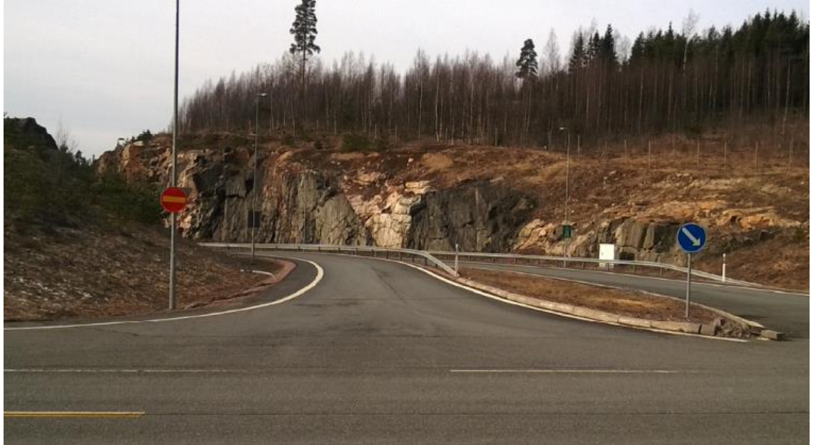
Kuva 22. Kielletyn ajosuunnan oikeanpuoleisen merkin voisi lisätä rampin päähän (Reini, A. 2015).
