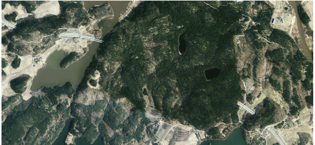
Kuva 23. Orosmäki-Karnainen-Lehmihaka -tunnelijakso (paikkatietoikkuna)
