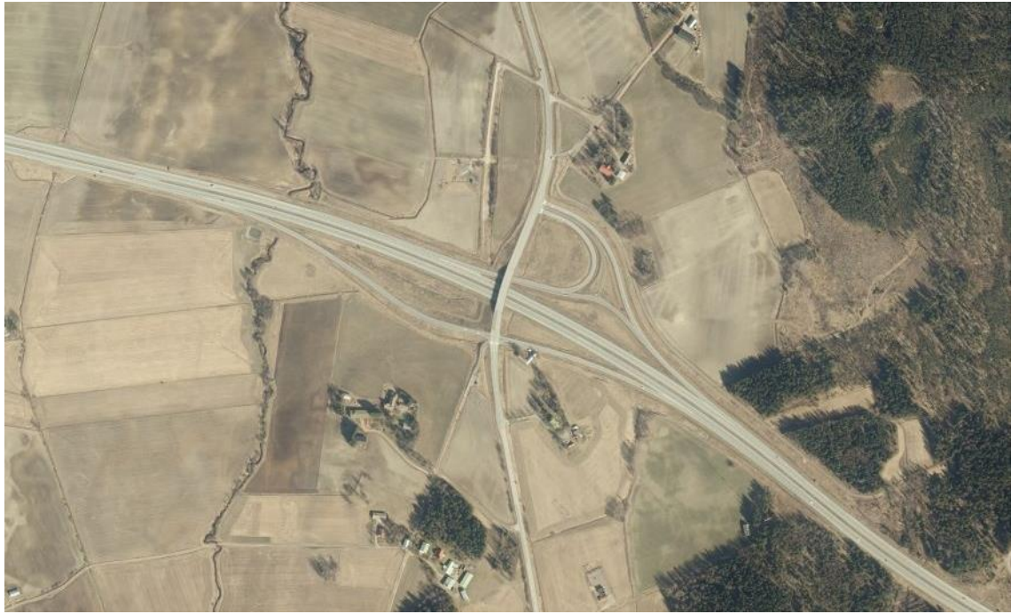
Kuva 14. Suomensjärven eritasoliittymä (paikkatietoikkuna)
