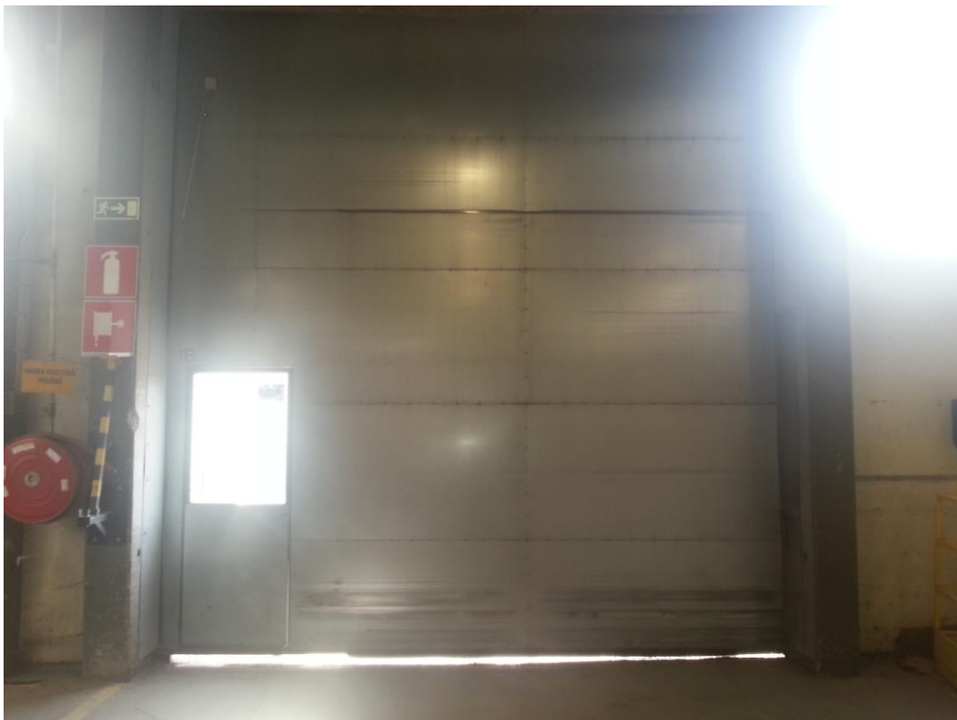
Kuva 10. Kiinteistön päädyssä oleva liukuovi
