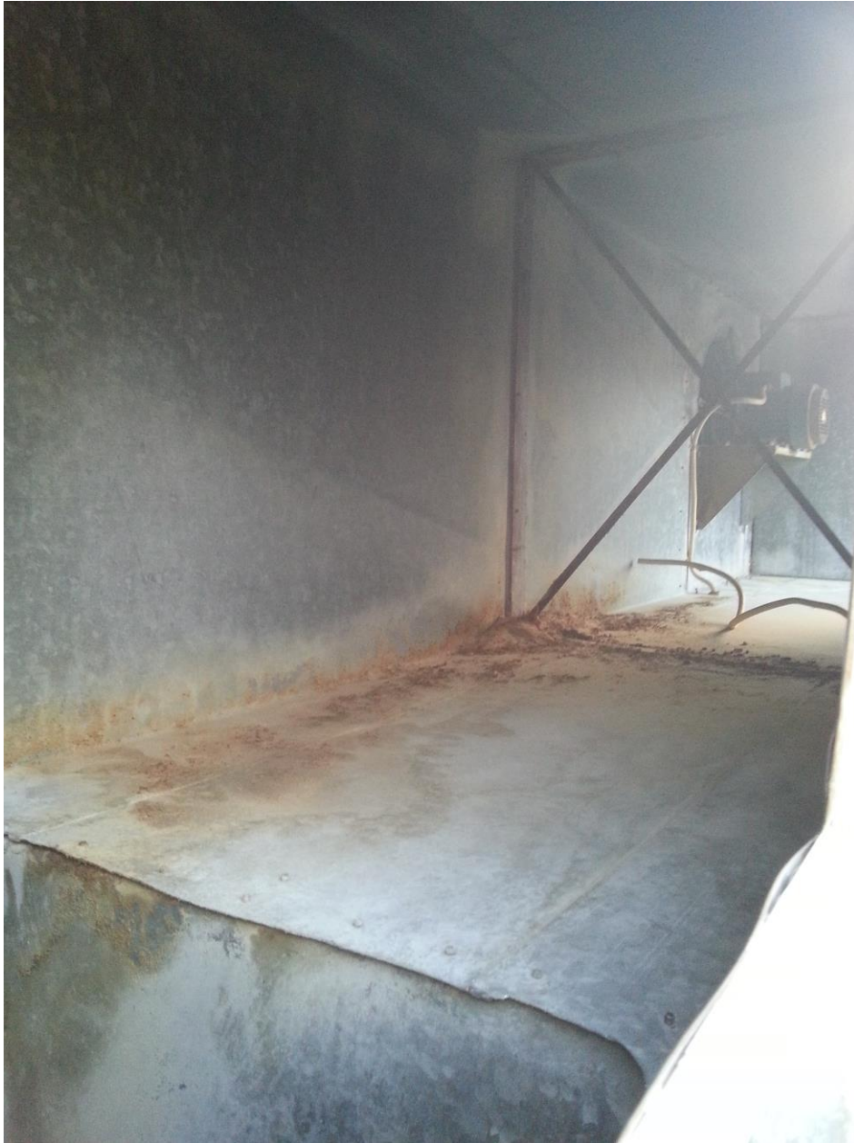
Kuva 9. Suodatinyksikön paluuilmanakanavan epäpuhtauksia
