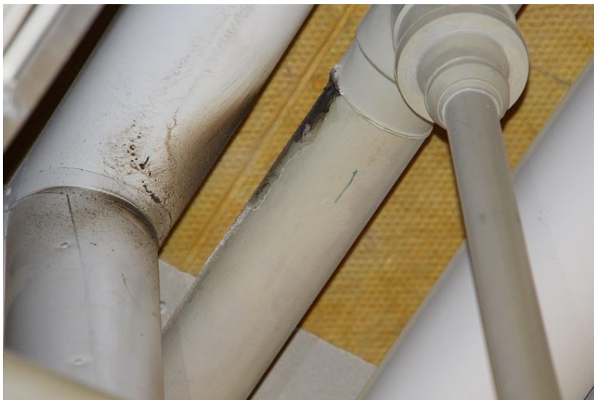
KUVA 13. Putkiston vuoto (Kuva: Janne Mäenpää 2015)
