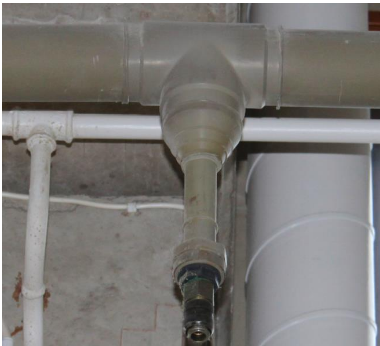
KUVA 9. Putken haaroitus (Kuva: Janne Mäenpää 2015)
