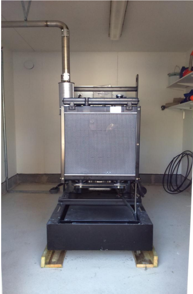
KUVA 6. Varavoimaa tuottava aggregaatti (Nieminen 2015).
