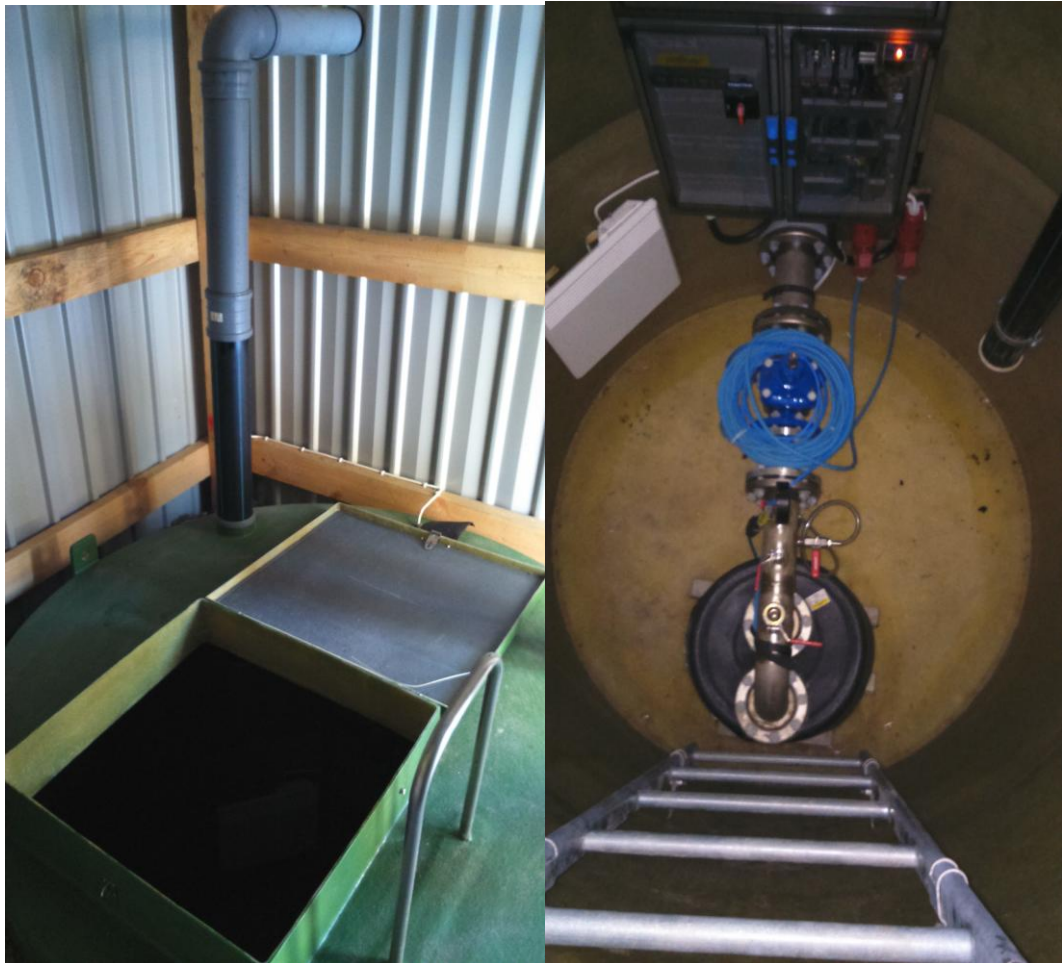
KUVA 4. Vedenottoaivo ulkoa- ja sisältäpäin (Nieminen 2015).
