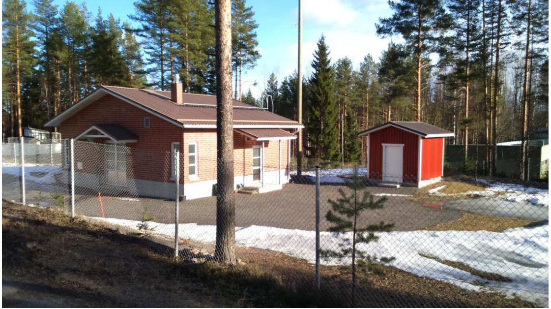
KUVA 1. Pertunmaan vedenkäsittelylaitos (Nieminen 2015).
