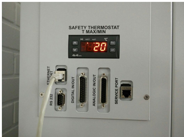
Kuva 7. Olosuhdekaapin termostaatti ja liitännät
