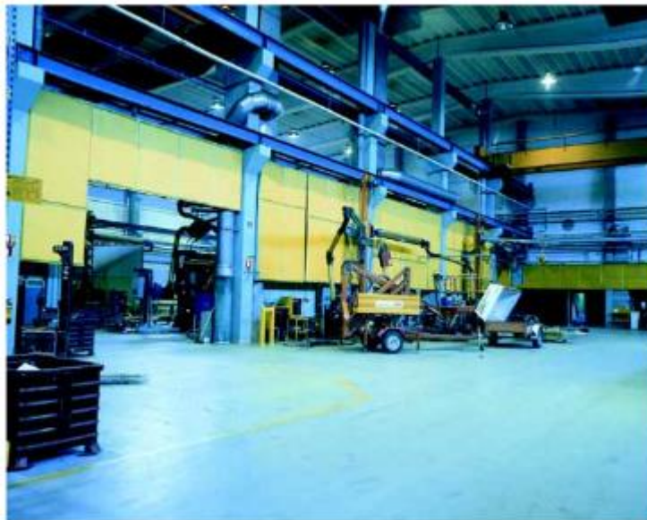
Kuva 3. Kiinteä akustiikkaseinä: Nutun-40 (Painepiste 2014.)
