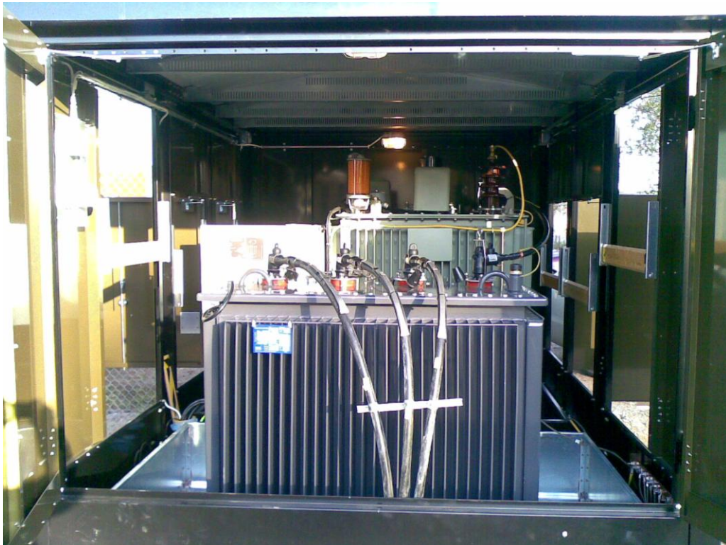
KUVIO 3. Etualalla kuvassa ZN-kytkentäinen maadoitusmuuntaja ja takana sammutuskuristin (Korpela 2015.)
