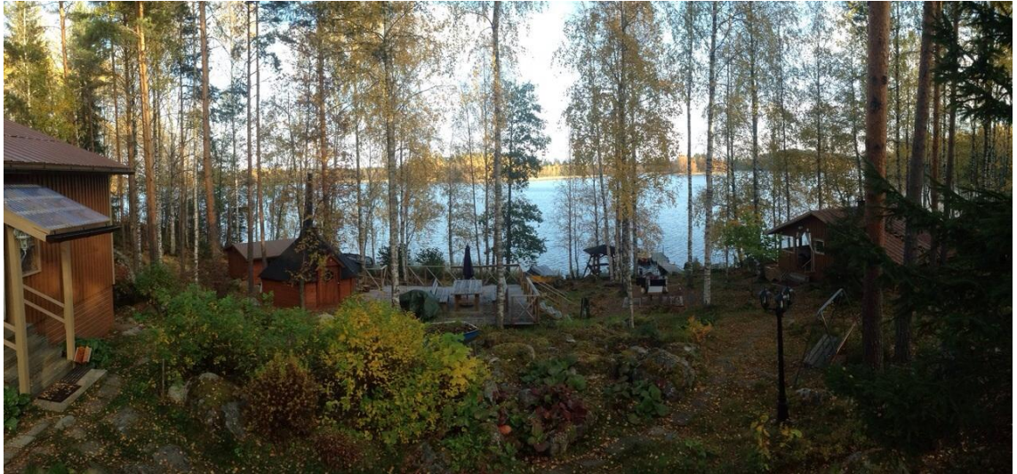
Kuvio 8. Yleiskuva maaperästä ja rakennuksien sijoittumisesta tontille
