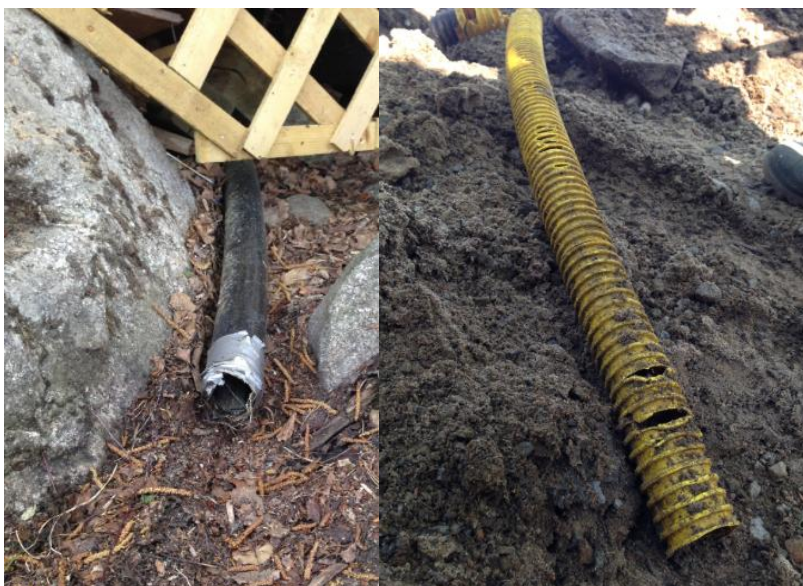
Kuvio 14. Saunarakennuksen vanhat viemäriputket
