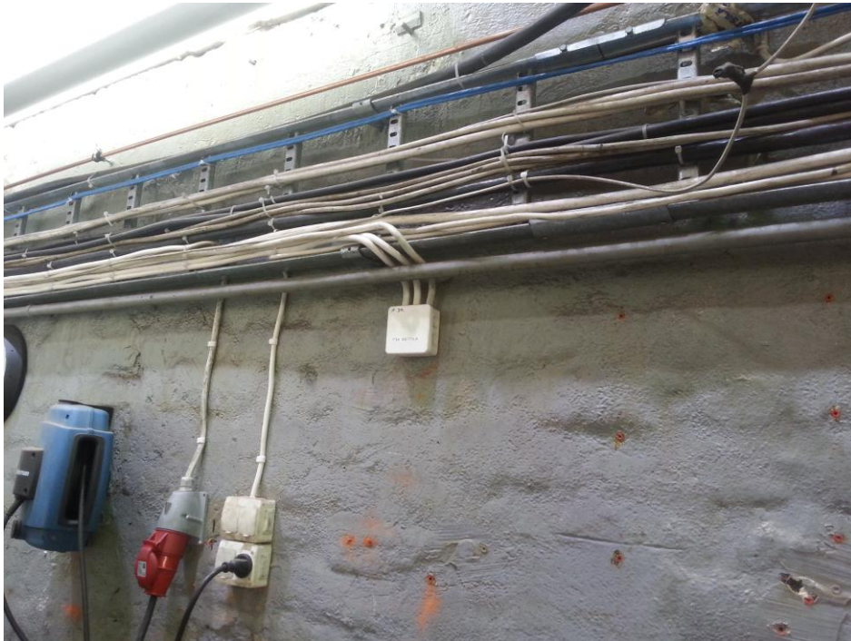
Kuvio 25. Korjatut sähköjohdot
