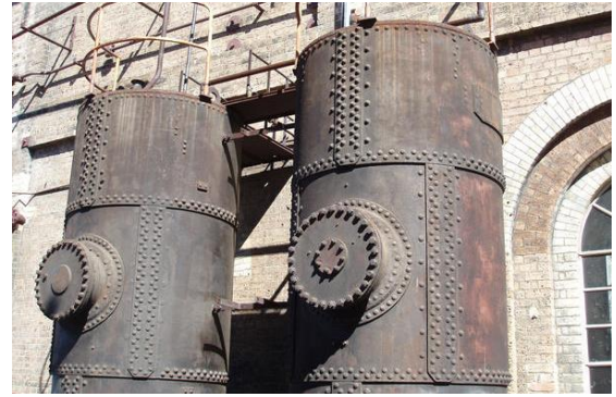
Kuva 8. Niittaamalla kasattuja höyrykattiloita
