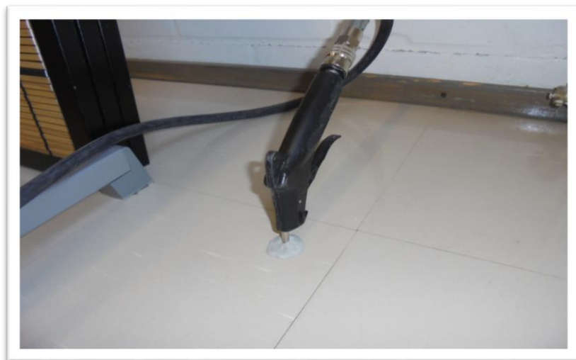
KUVA 4. Tiivistetty kaasunlaskuaukko lattiassa (Tuukkanen 2015)
