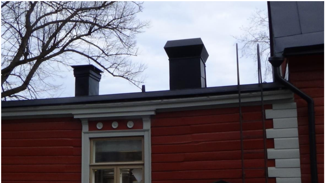
Kuva 7. Keittiön huippuumuri asennettuna ja maalattuna katon väriin.
