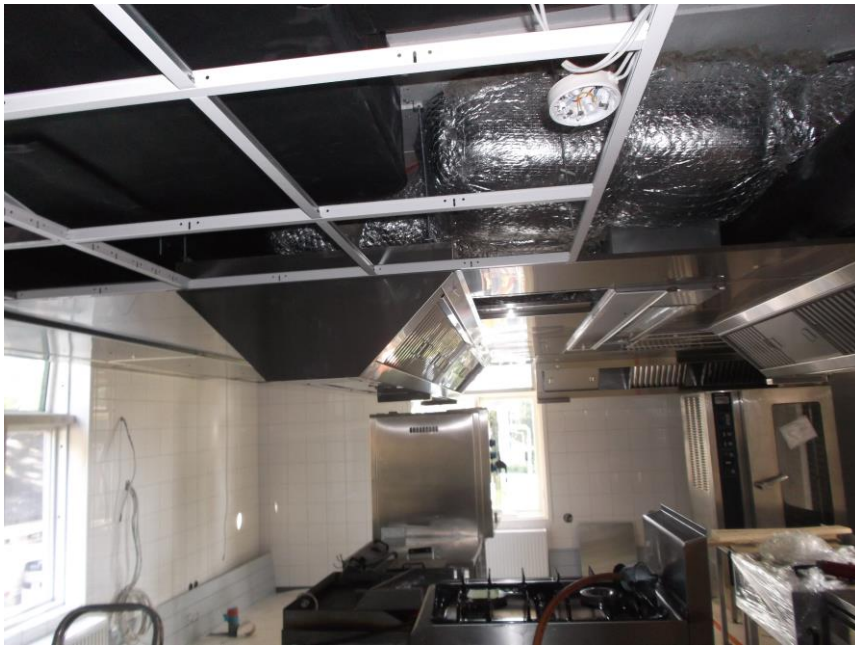
Kuva 13. Kiinteiden keittiökalusteiden asennusta matalalle jääneiden päätelaitteiden alle.
