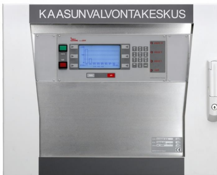
Kuva 1. SCAN 200E -kaasunvalvontakeskus. [6]
