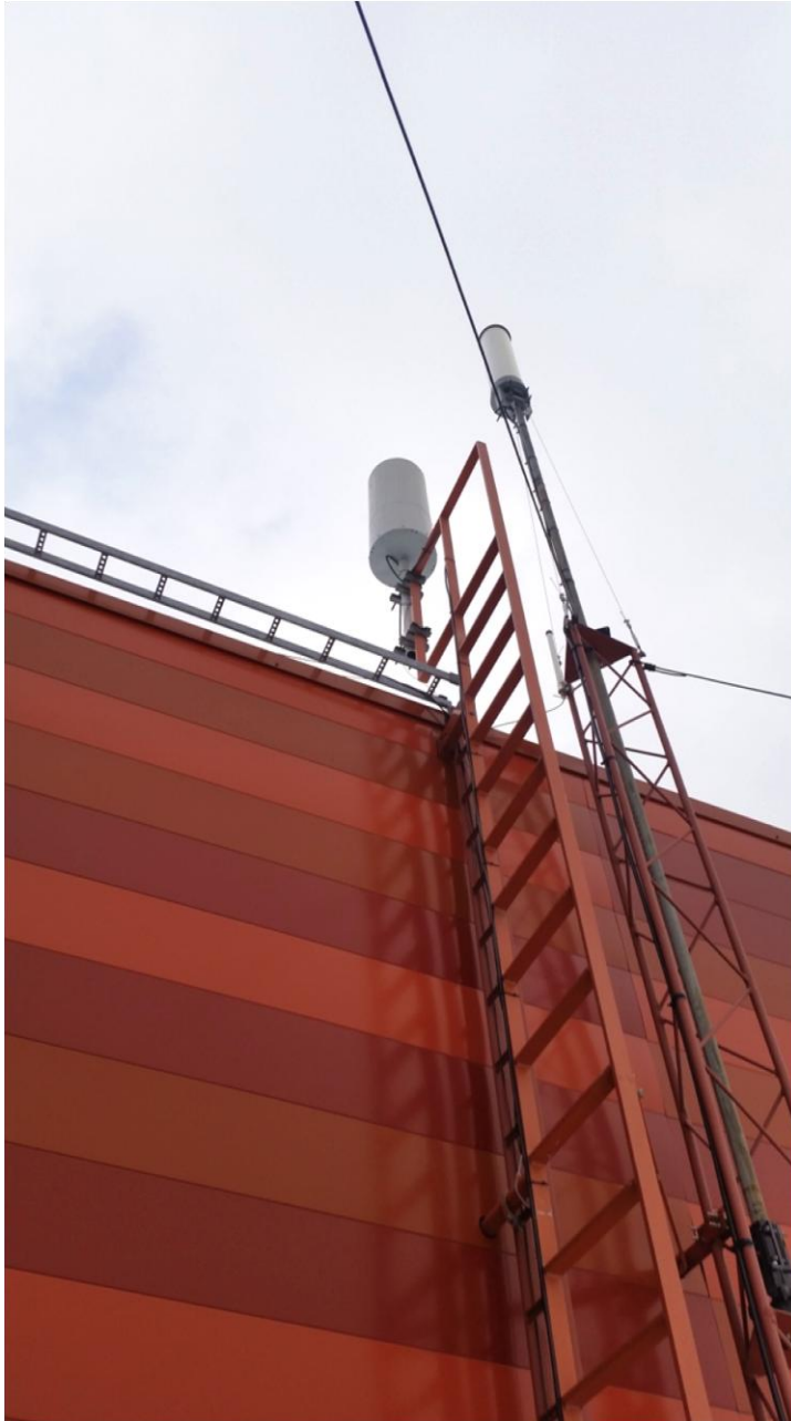
Kuva 5. Käytössä oleva ympärisäteilevä antenni (vasemmalla).
