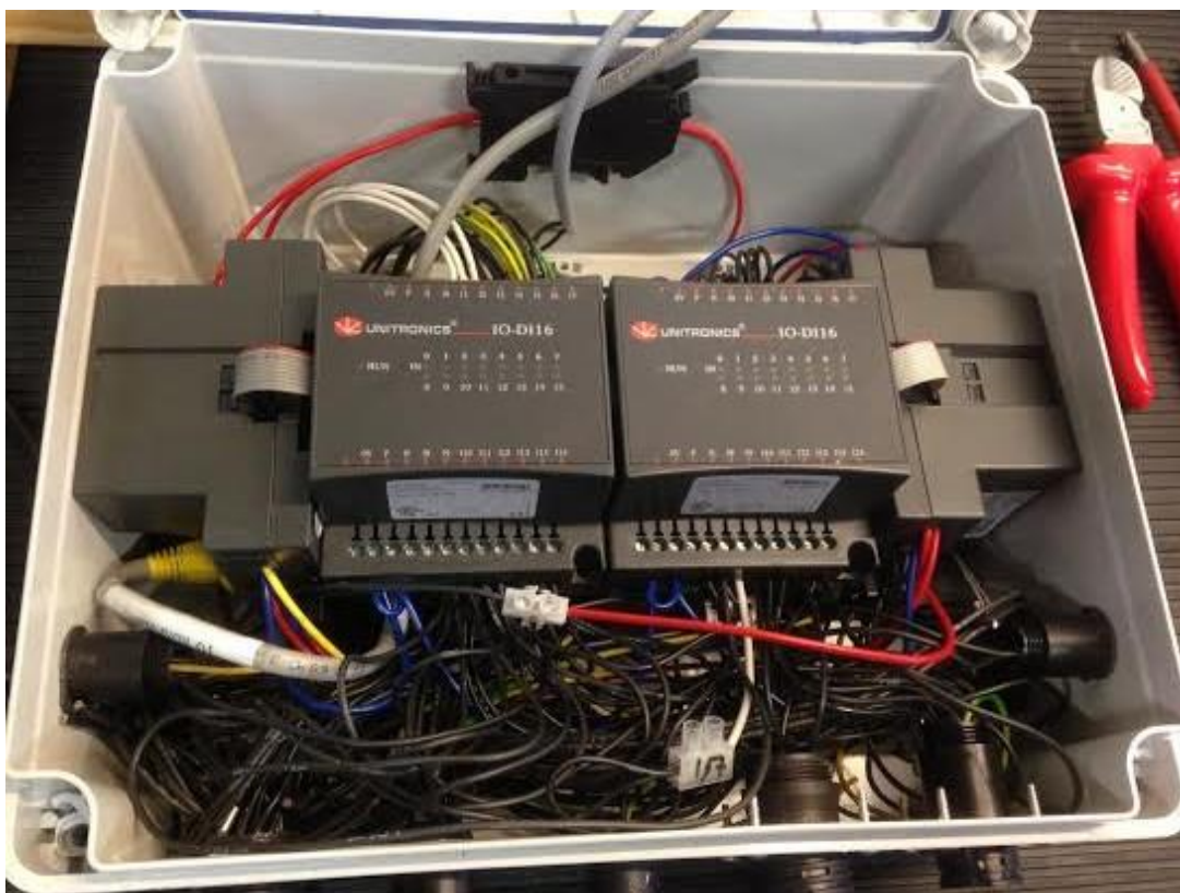
Installation av I/O-modulerna.
