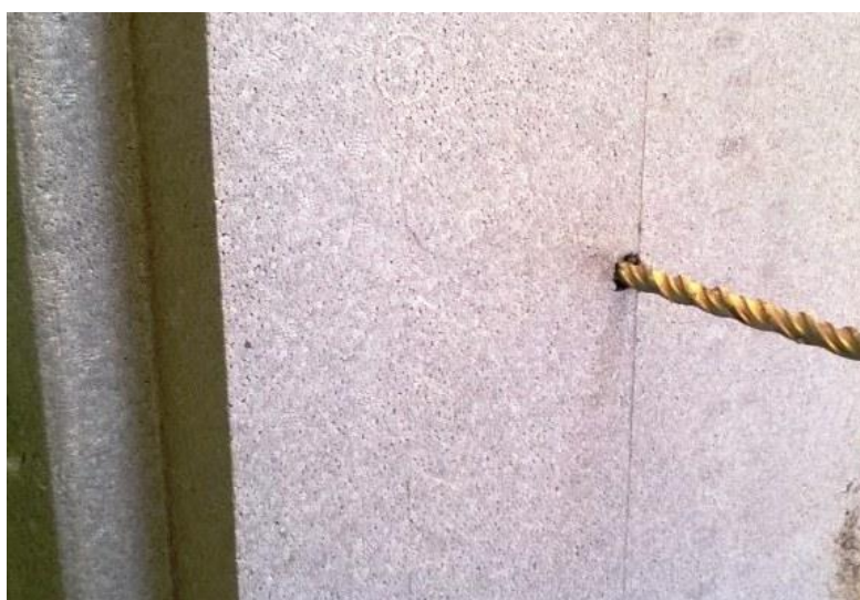
Kuva 11. Asennuskaapelin reiän poraus [4].
