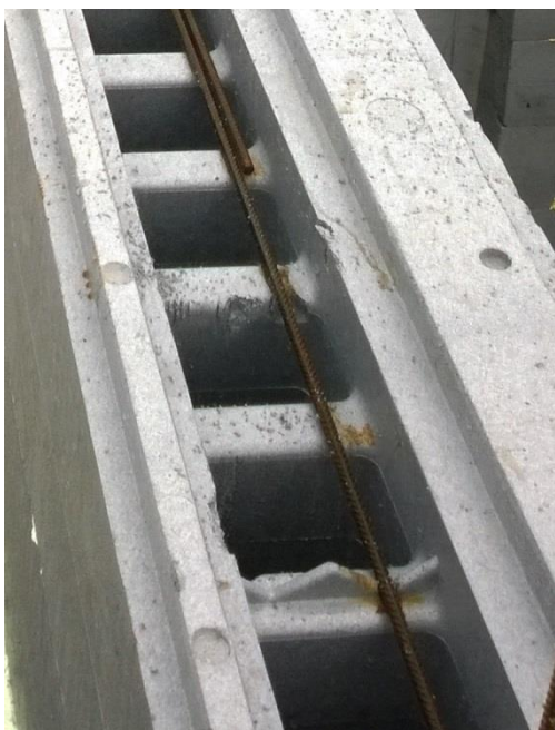
Kuva 3. Passiivitriploharkko ja rakennesuunnitelman mukainen vaakaraudoite [4].
