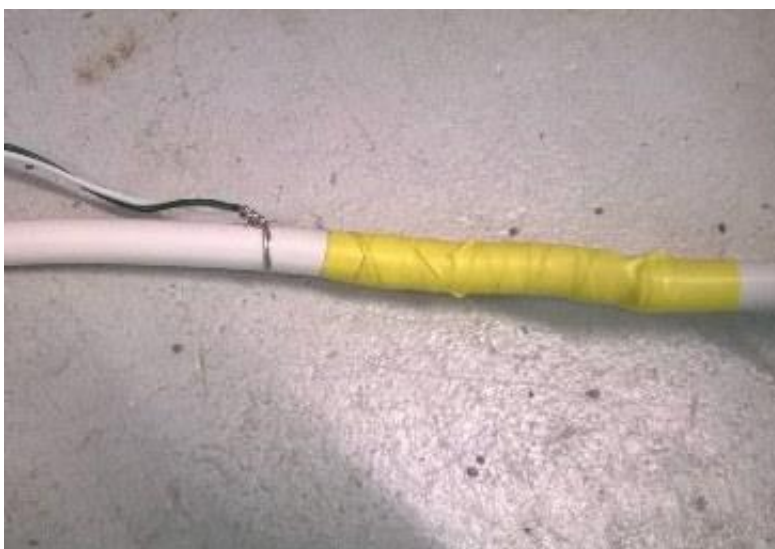
Kuva 10. Asennuskaapeli teipattuna ja mittausjohtimet asennettuna [4].
